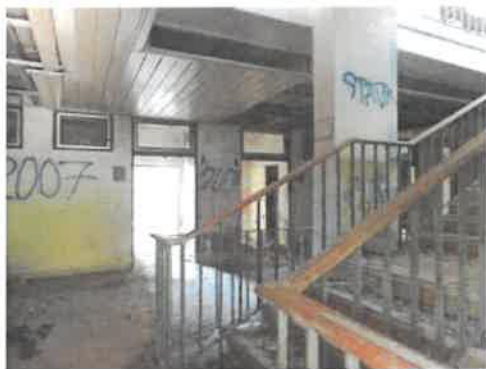
vstup do objektu
