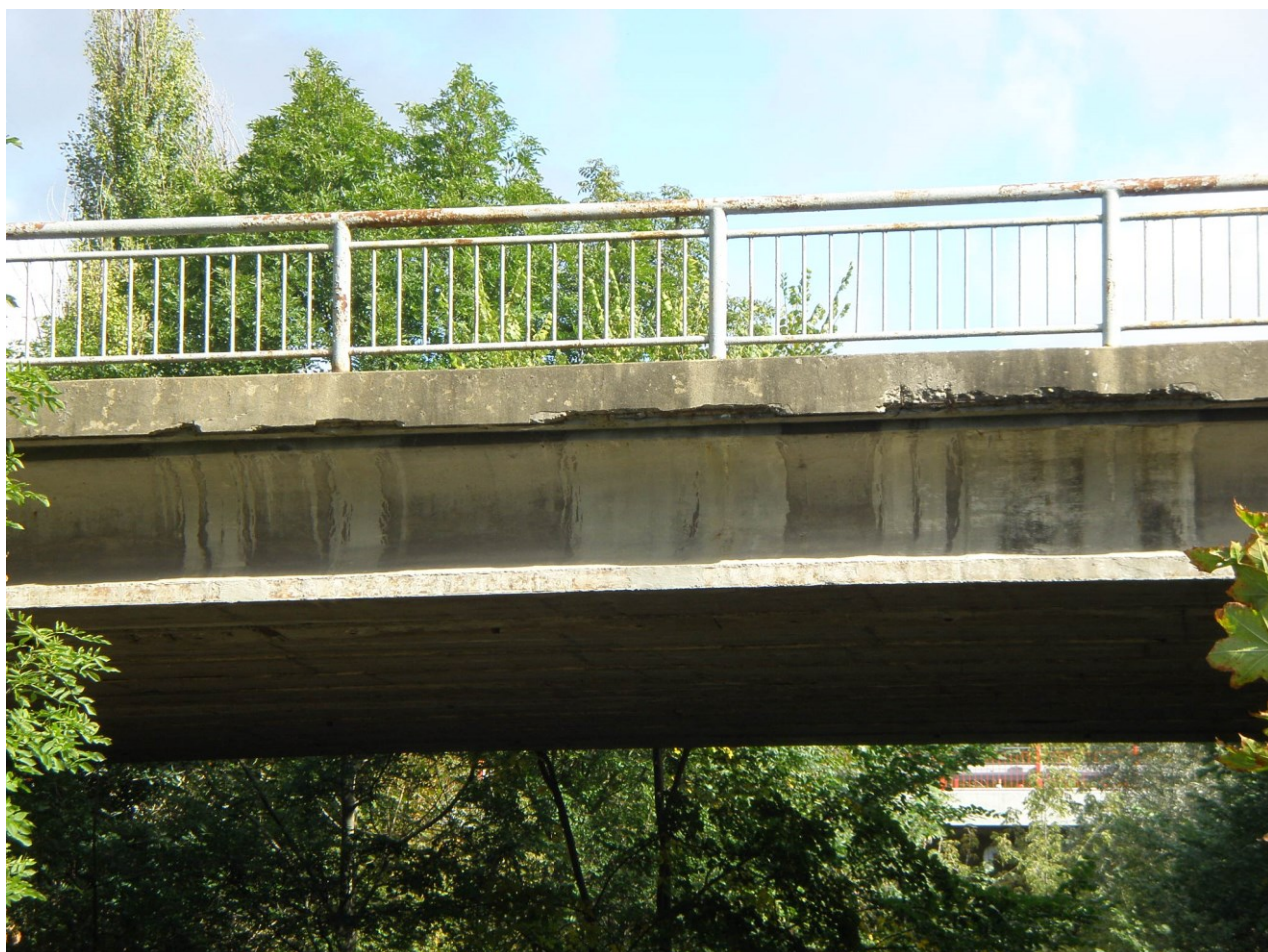
Rekonstrukce mostu 25814-2 Hlíňany přes železnici, místní komunikace a řeku Břelinu
