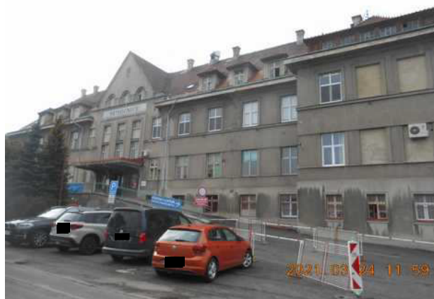
Přední pohled z ulice U Nemocnice hlavní objekt
