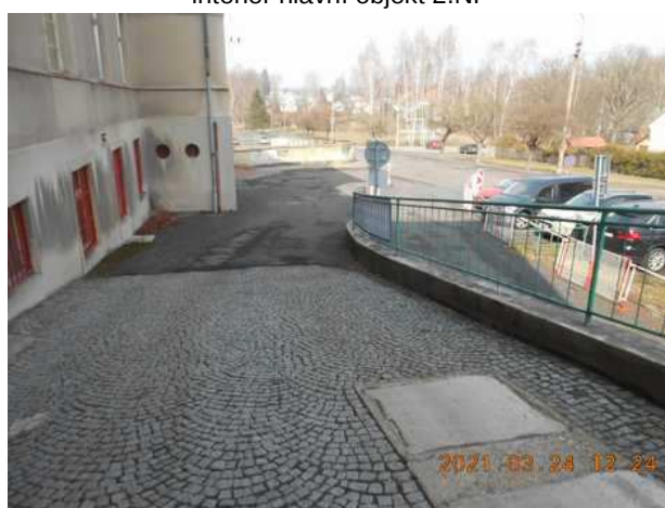
Hlavní vstup z ulice U Nemocnice hlavní objekt
