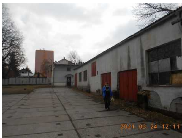
objekt dílny, sklady
