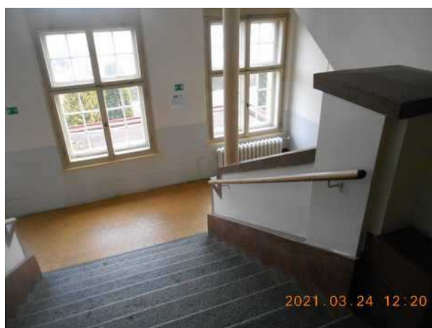
schodiště do 2.NP
