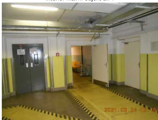
interiér hlavní objekt 1.PP
