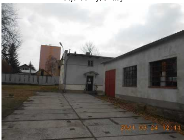
objekt dílny, sklady,
