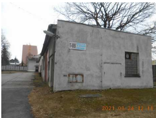
objekt dílny, sklady
