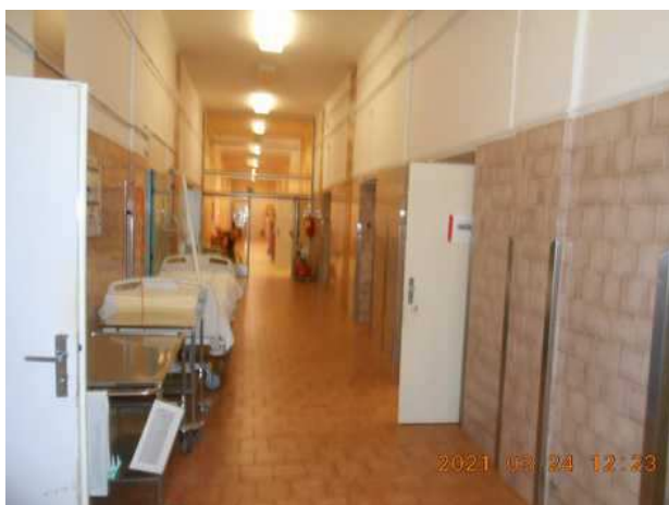
interiér hlavní objekt 2.NP
