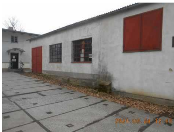
objekt dílny, sklady
