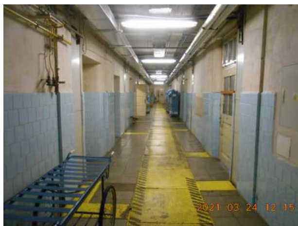
interiér hlavní objekt 1.PP
