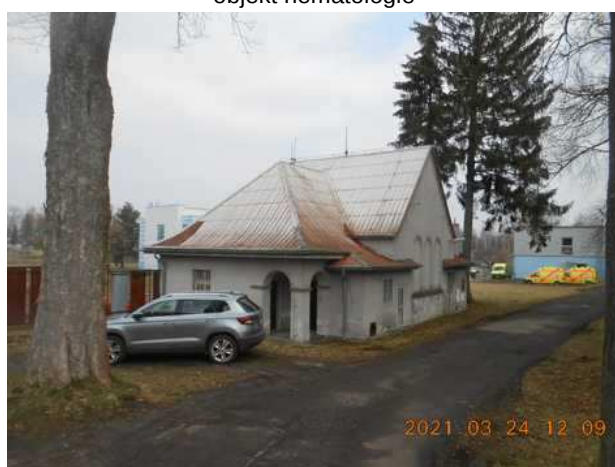
objekt bývalé márnice
