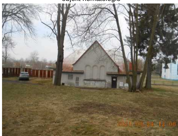
objekt bývalé márnice
