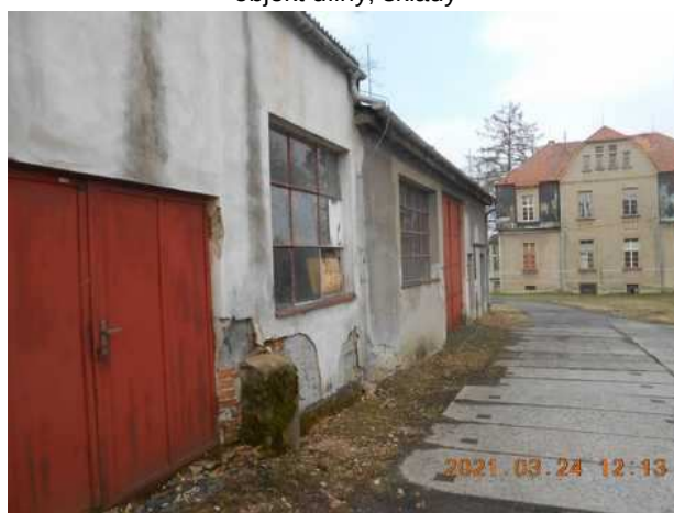
objekt dílny, sklady
