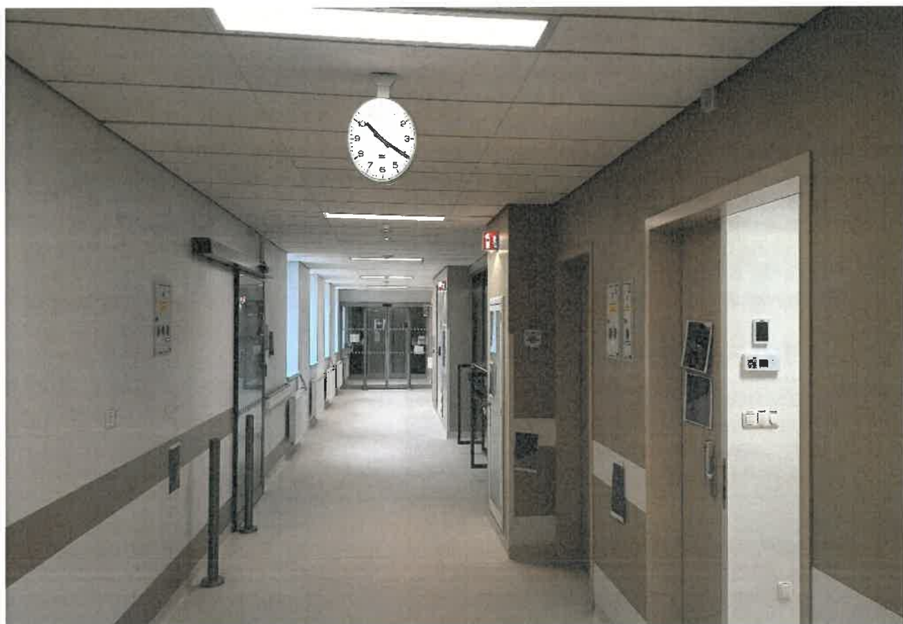
Fotografie z probíhající stavby za rok 2024:
