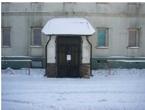
hlavní vstup od objektu
