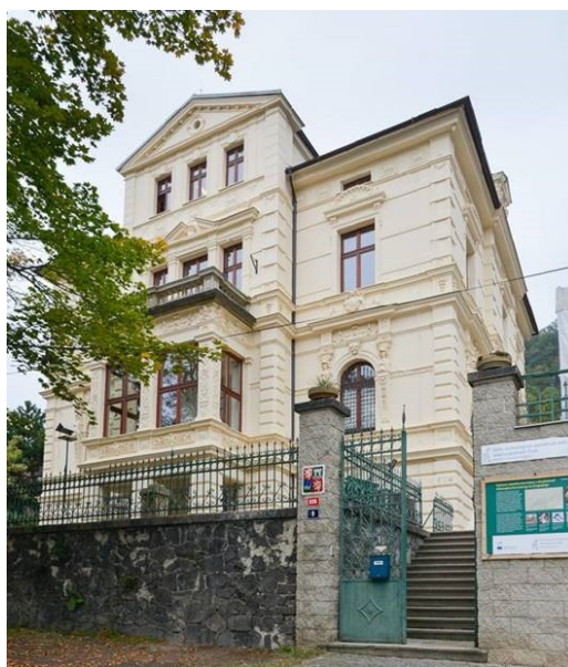
Budova po opravě
