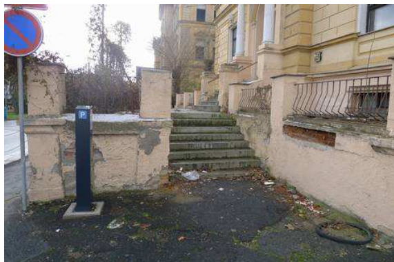
hlavní přístupové schodiště
