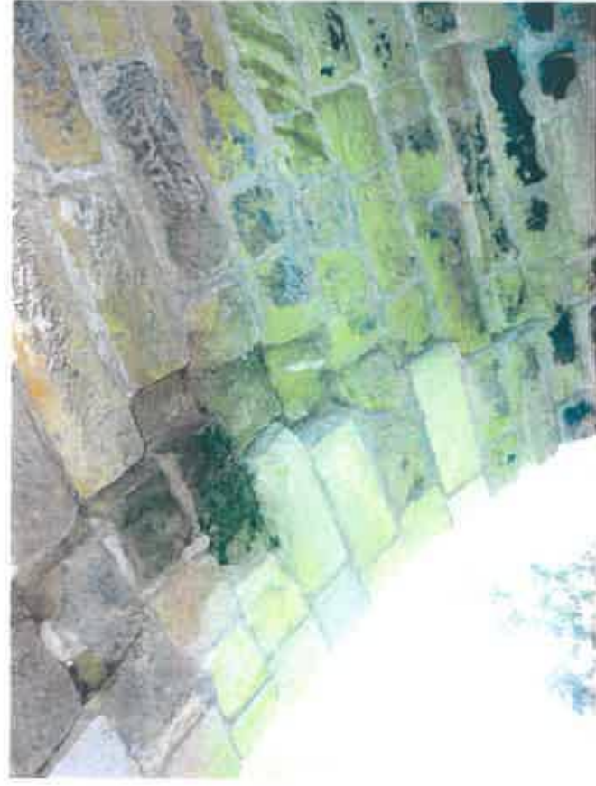
Odtržení 1 řady pískovců v otvoru č. 34
