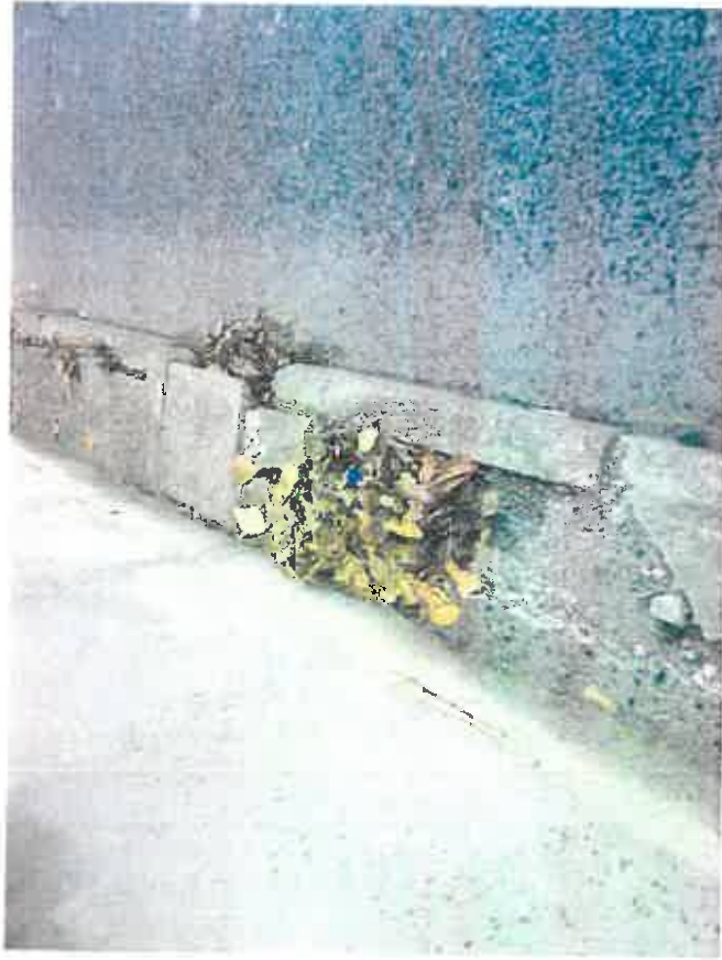
Rozlamané obruby v krajnici komunikace
