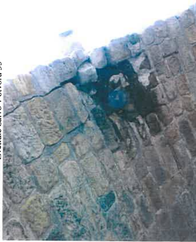
Rozpad kamenů u klenáku
