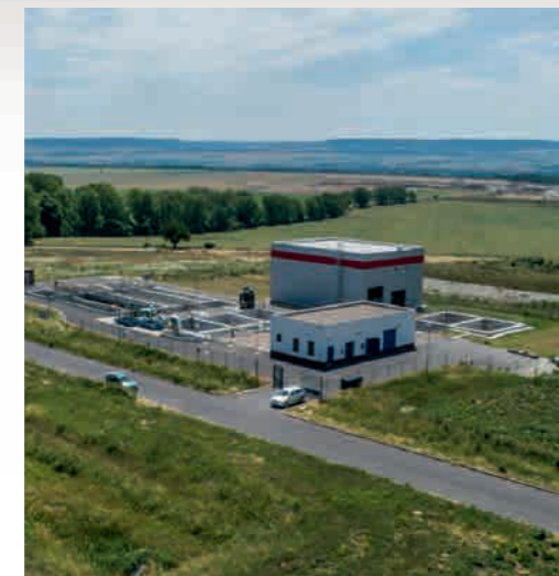
Water treatment plant and treatment plant for cleaning technological wastewaters / čistírna odpadních a technologických vod
