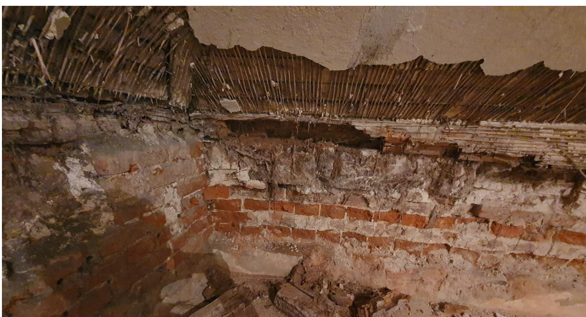
Totéž místo při rozebírání napadeného dřevěného věnce. Dole detail napadení.
