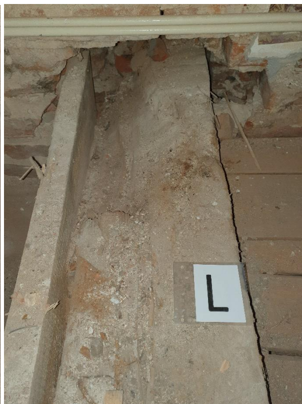
10. Průzkum 2.NP (expozice). Rozebraná podlaha podél jižní stěny. Dole napadené trámy, opatřené příložkami během opravy z 90.let.
