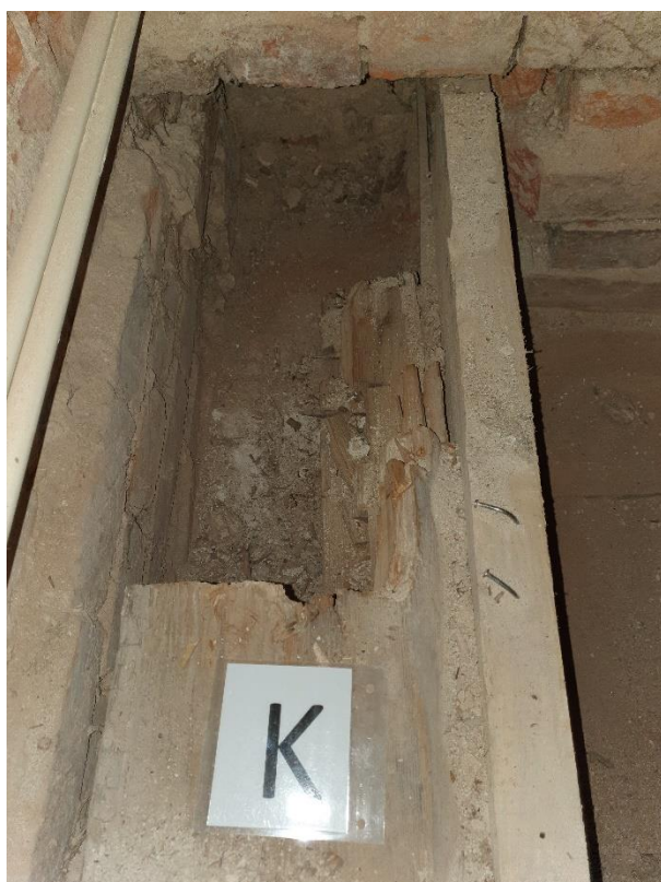
10. Průzkum 2.NP (expozice). Rozebraná podlaha podél jižní stěny. Dole napadené trámy, opatřené příložkami během opravy z 90.let.
