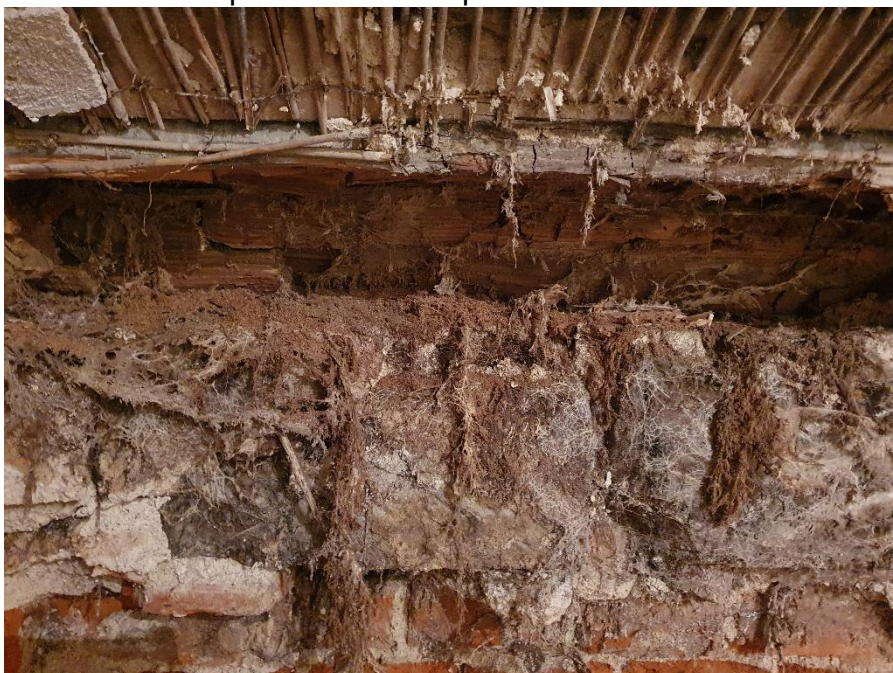
Totéž místo při rozebírání napadeného dřevěného věnce. Dole detail napadení.
