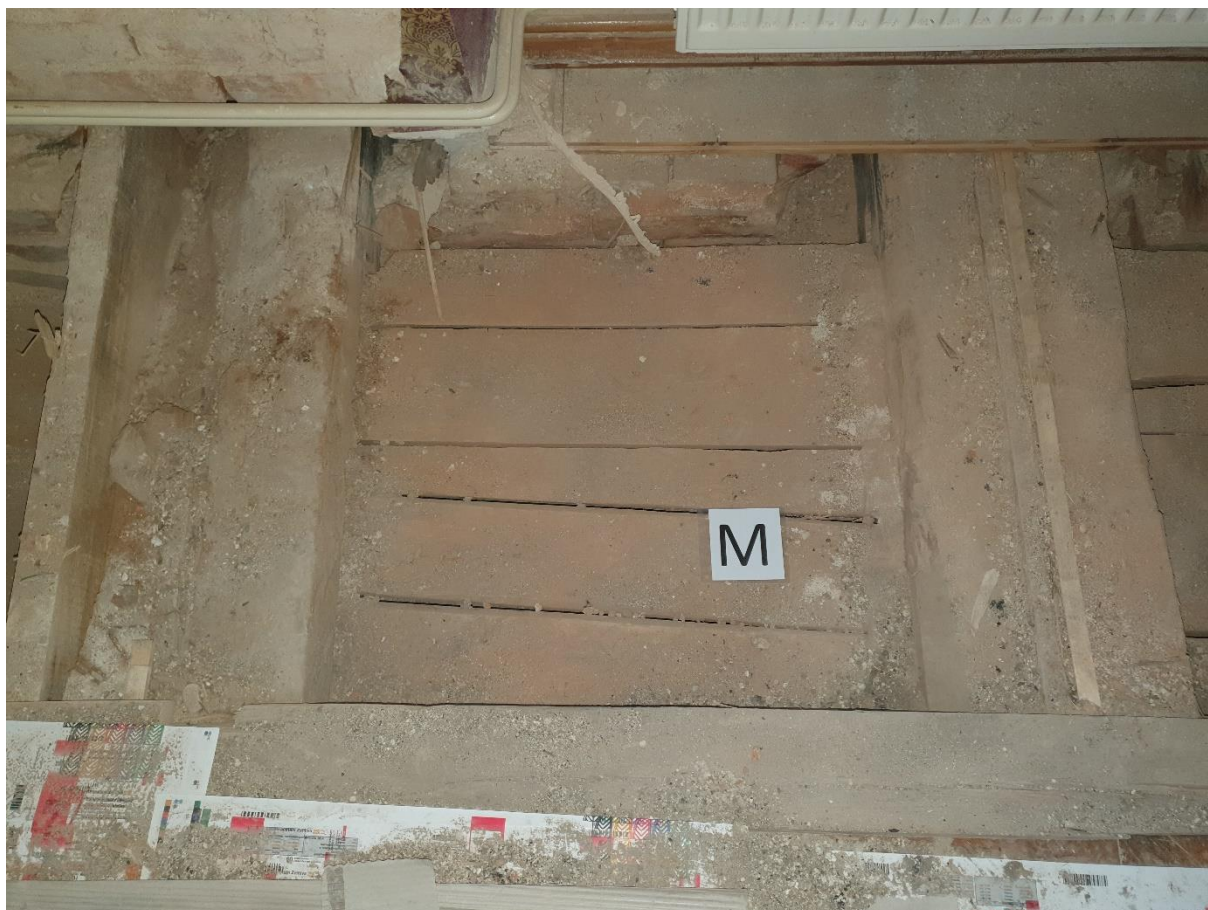
10. Průzkum 2.NP (expozice). Rozebraná podlaha podél jižní stěny. Dole napadené trámy, opatřené příložkami během opravy z 90.let.
