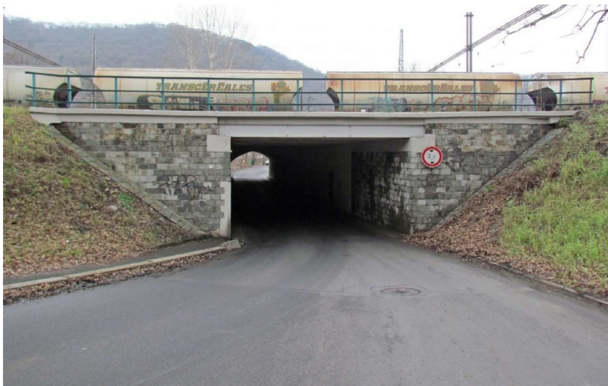
Vjezd do podjezdu směr Ústí n. L.
