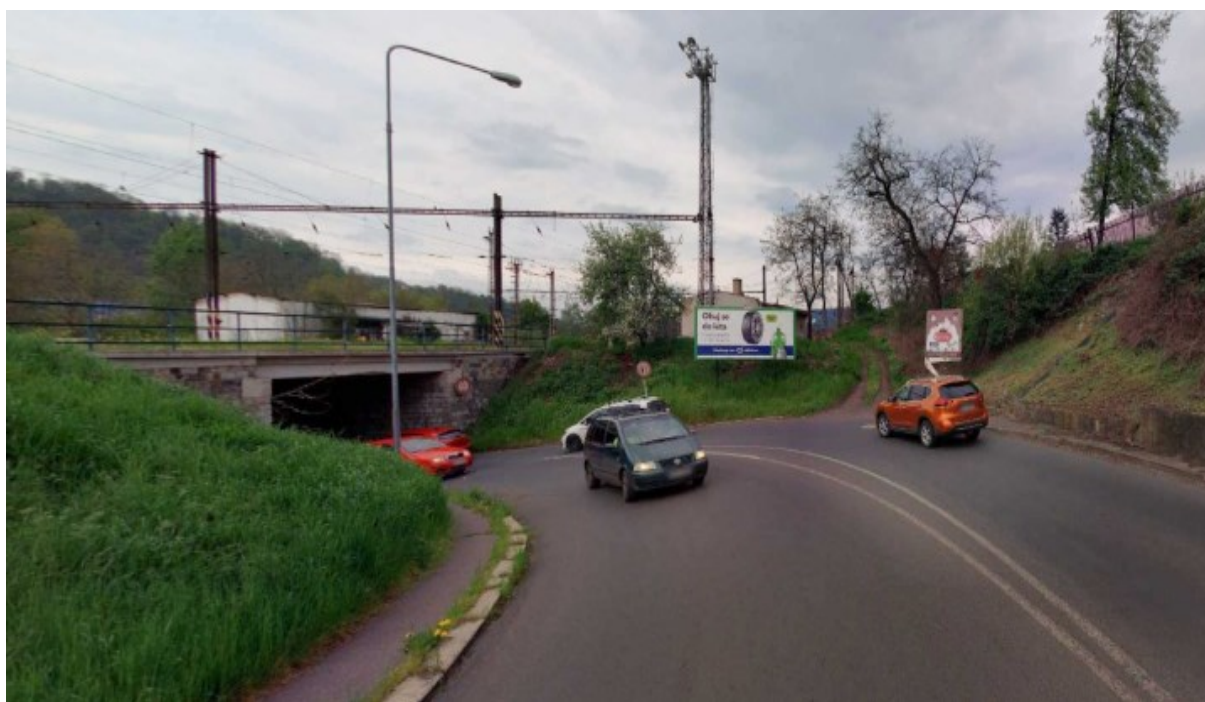
Nájezd k podjezdu směr Ústí n. L.
