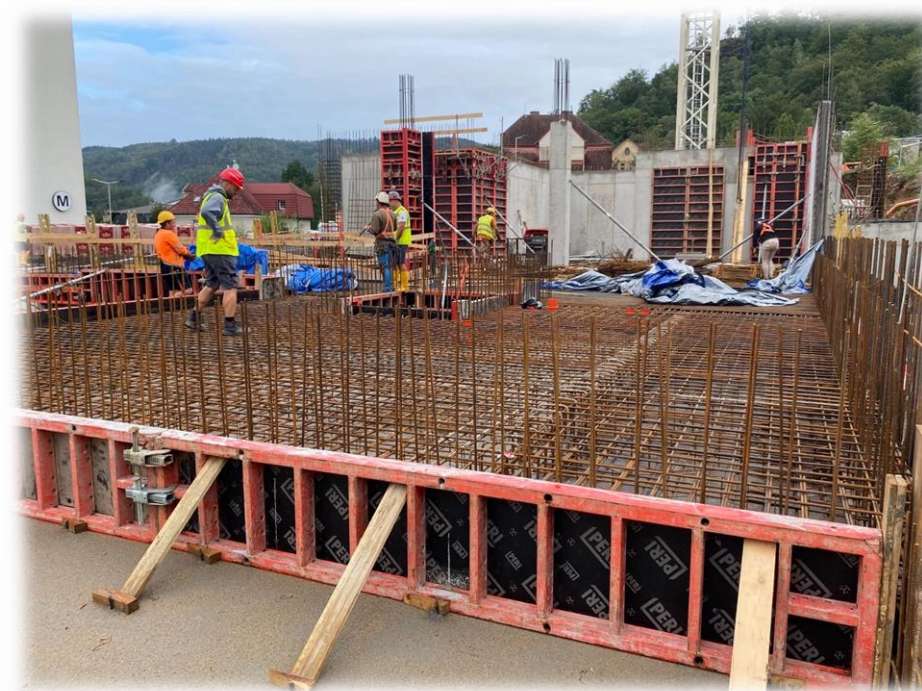
Probíhající práce II. Etapy
