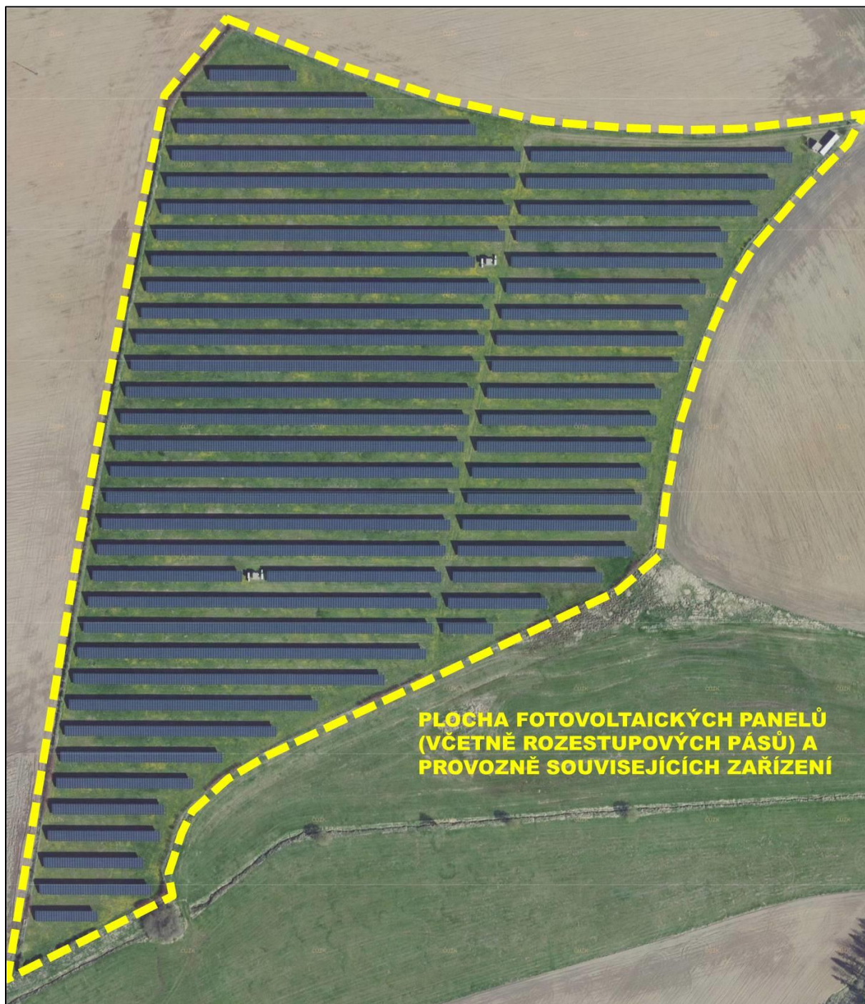
Obrázek 5: Ukázka plochy fotovoltaických panelů (včetně rozestupových pásů) a provozně souvisejících zařízení
