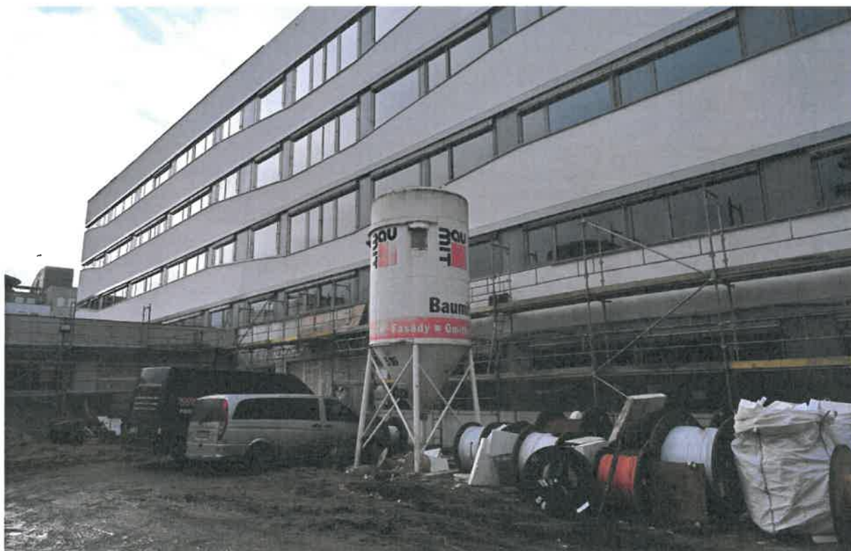
Fotografie z probíhající výstavby za rok 2023:
