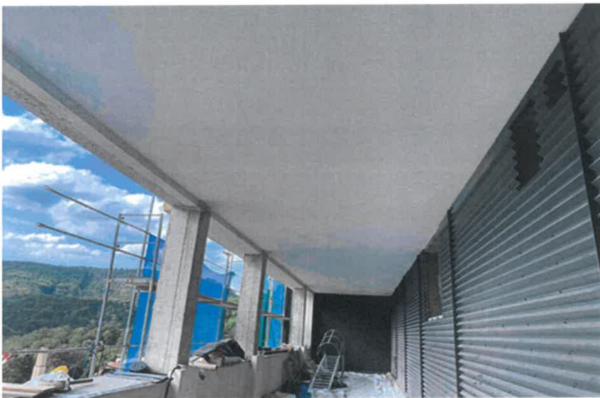
Fotografie z probíhající stavby
