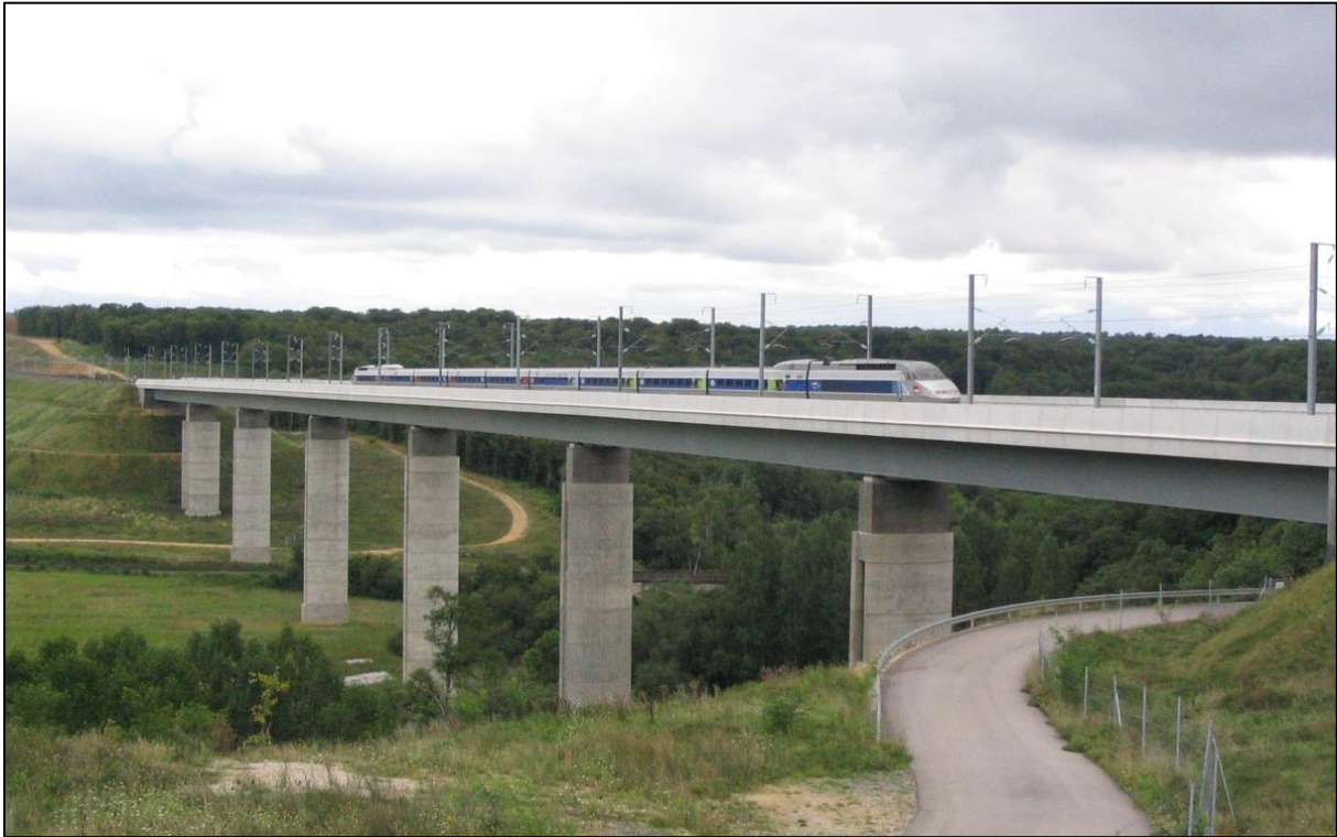
Obrázek 12: Ukázka vedení vysokorychlostní trati po estakádě: Viaduc de Jaulny, Francie (Zdroj: International Database and Gallery of Structures, Structurae.net)
