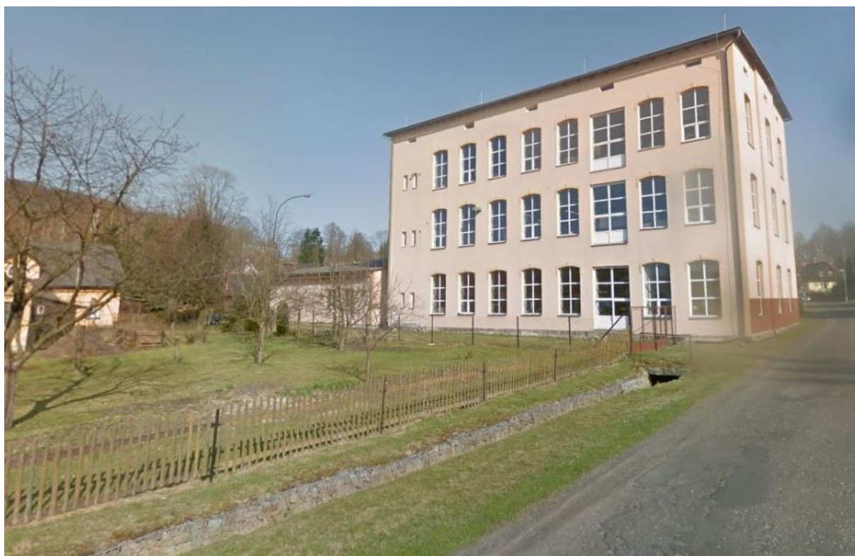
Obr. 8 – Mikulášovický potok v Mikulášovicích vedený pod průmyslovým objektem
