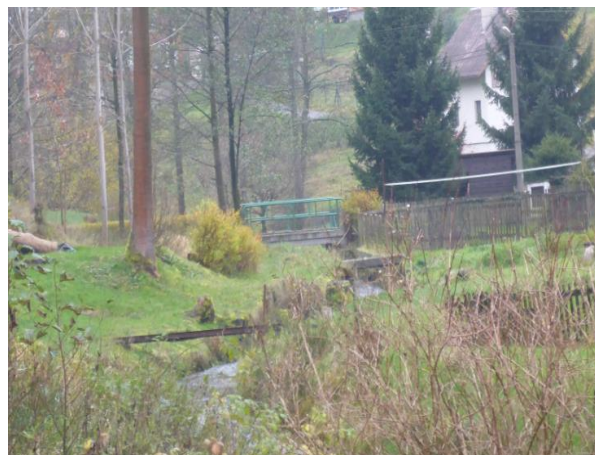
Obr. 116. Řada drobných lávek na toku (-733975, -941367)
