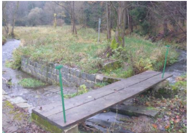
Obr. 19. Rozdělovací objekt – náhon na MVE (-736759, -943077)
