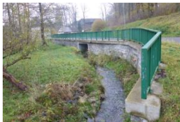
Obr. 132. Silniční most v ř. km 3,989 (-732730, -940418)
