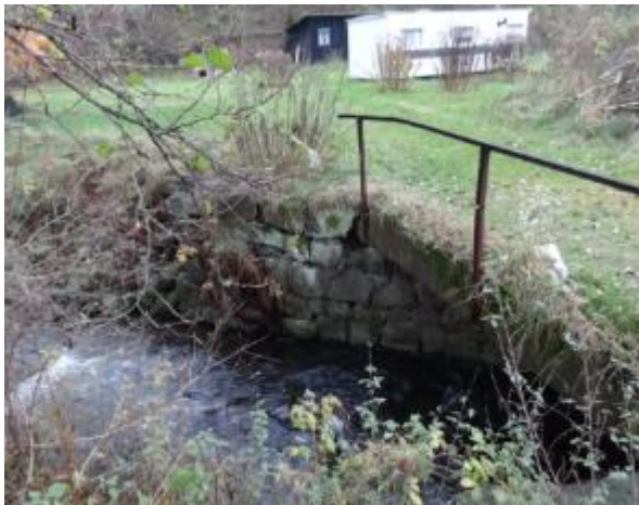
Obr. 50. Mostek v ř. km 1,532 (-738107, -942271)
