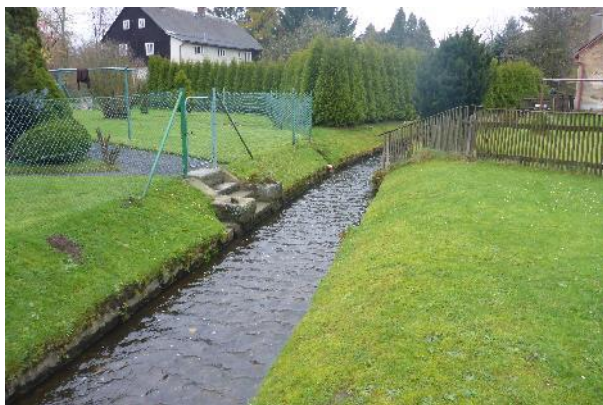
Obr. 164. Složený profil v dolní části úseku (-731439, -942904)
