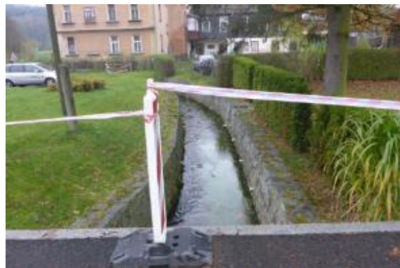
Obr. 128. Koryto před propustkem (-733163, -940631)
