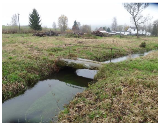
Obr. 62. Kamenná lávka ř. km 6,728, přírodní charakter koryta toku (-735739, -939264)
