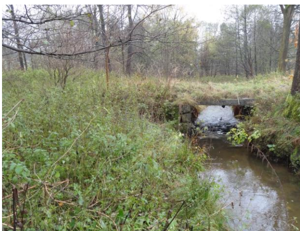
Obr. 68. Mostek v ř. km 8,737 (-735686, -937878)
