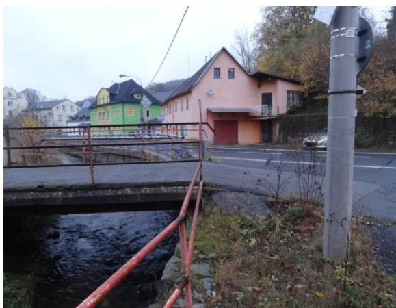
Obr. 42. Mostek přes potok (-738555, -943385)
