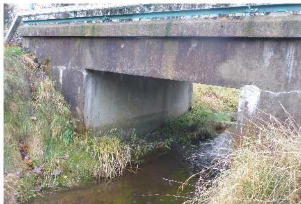
Obr. 183. Železniční most v ř.km 2,377 (-730520, -941530)
