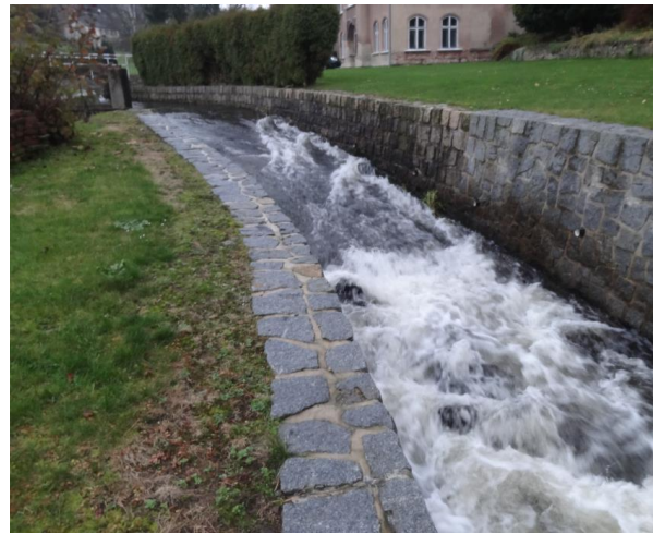
Obr. 49. Obdélníkové koryto – strmější úsek, ř. km 1,016 až 0,962
