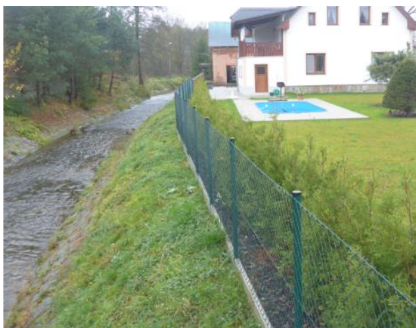
Obr. 31. Lichoběžníkové koryto s opevněním (-732876, -942989)
