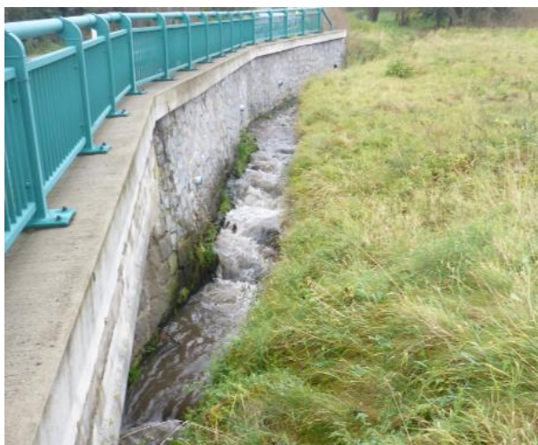
Obr. 82. Začátek úseku u silničního mostu (-734754, -943742)
