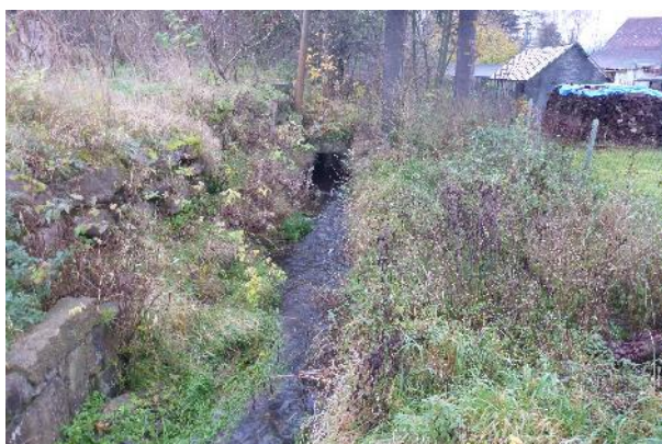
Obr. 178. Zakrytý úsek pod mostem M-02 (-730950, -942055)
