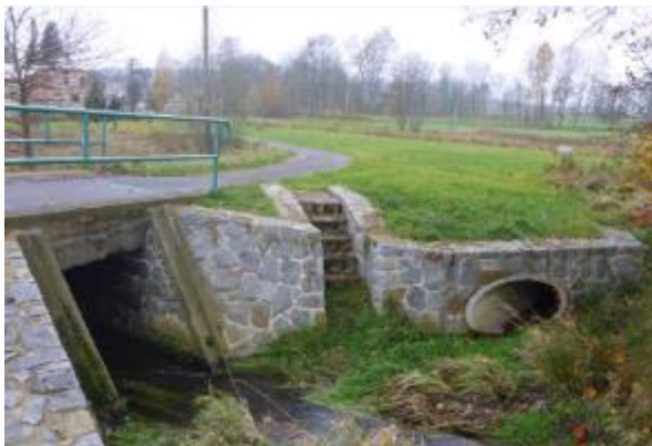
Obr. 123. Vtok do mostu v ř. km 3,130 (-733218, -940912)
