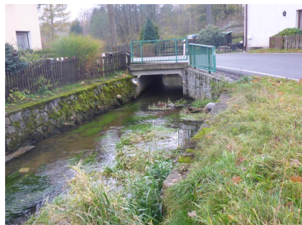
Obr. 120. Silniční most ř. km 2,549 (-733710, -941073)
