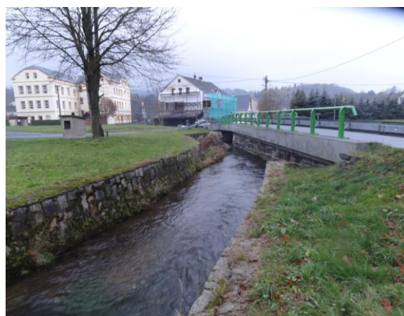
Obr. 47. Most se šikmým nátokem, ř. km 0,6430 (-738457, -943023)
