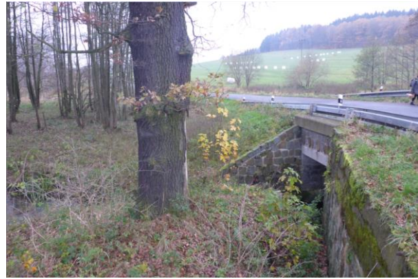
Obr. 112. Silniční most v ř. km 0,785 - výtok (-734145, -942334)
