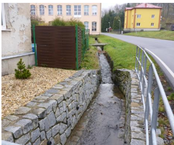
Obr. 96. Koryto mezi průmyslovým areálem a silnicí (-732988, -946062)
