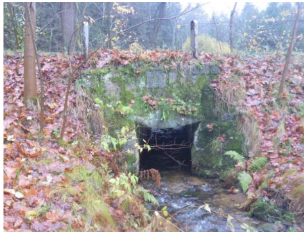
Obr. 40. Mostek nad částí obce Staré Hrabčíc (-730620, -945555)
