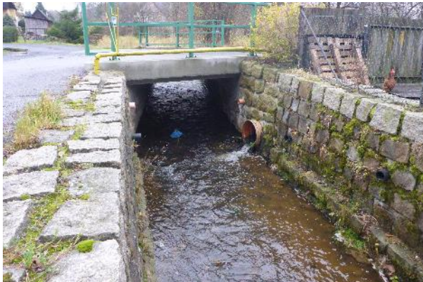
Obr. 162. Most M-11 v ř.km 0,748 (-731551, -942985)
