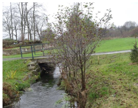
Obr. 63. Most v ř. km 7,475 (-735302, -938982)
