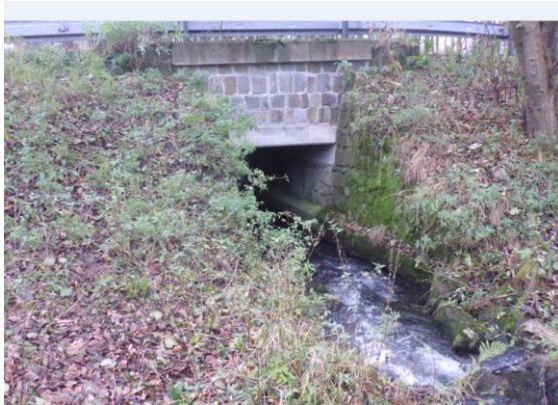
Obr. 111. Silniční most v ř. km 0,785 - vtok (-734145, -942334)
