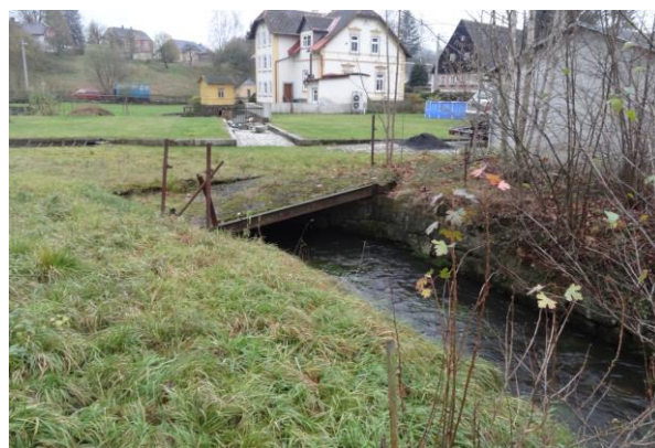
Obr. 53. Dva na sebe navazující propustky v ř. km 2,906 až 2,881 (-737699, -941400)
