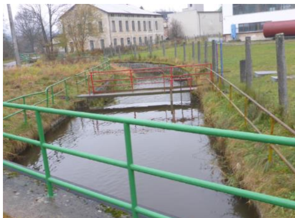
Obr. 30. Jez s opevněným korytem (-732990, -732990)
