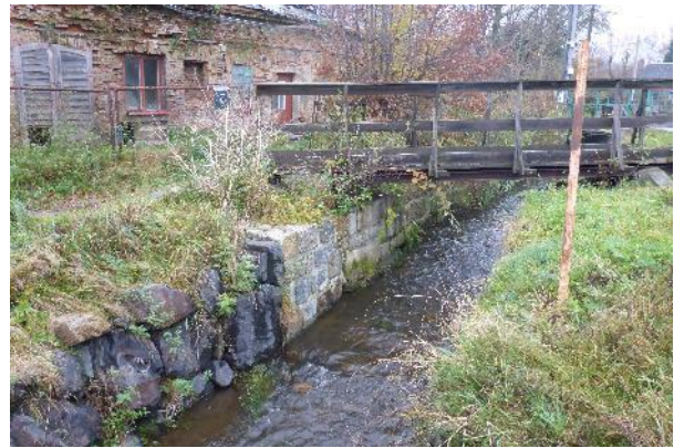
Obr. 169. Provizorní lávka pro pěší (-731237, -942637)
