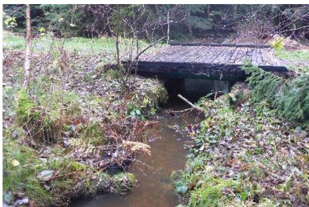
Obr. 184. Mostek na lesní cestě (-730174, -941440)
