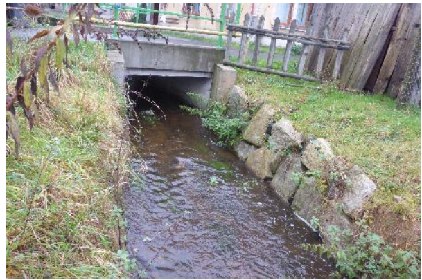
Obr. 175. Most M-03 v ř.km 1,730 – konec úseku (-731074, -942243)
