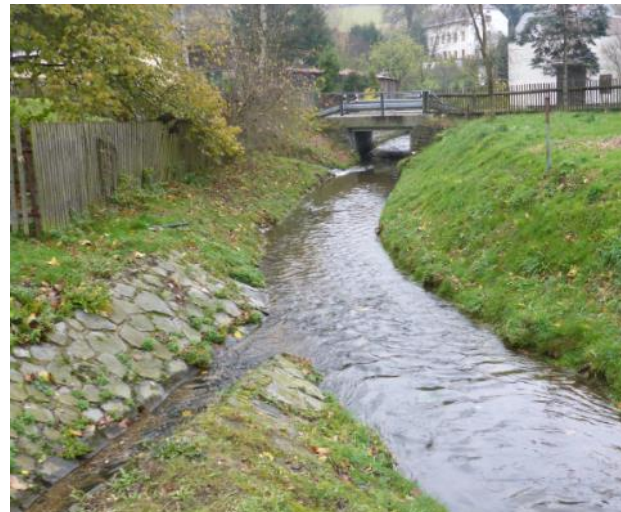
Obr. 89. Lichoběžníkové koryto s levostraným přítokem (-734355, -945391)
