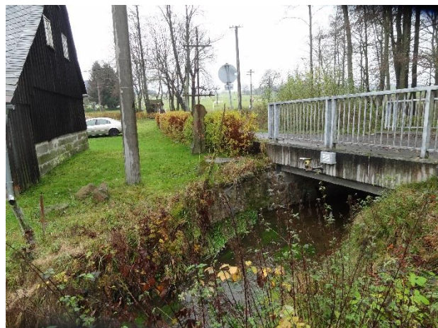
Obr. 67. Most v ř. km 8,4891 (-735632, -938111)
