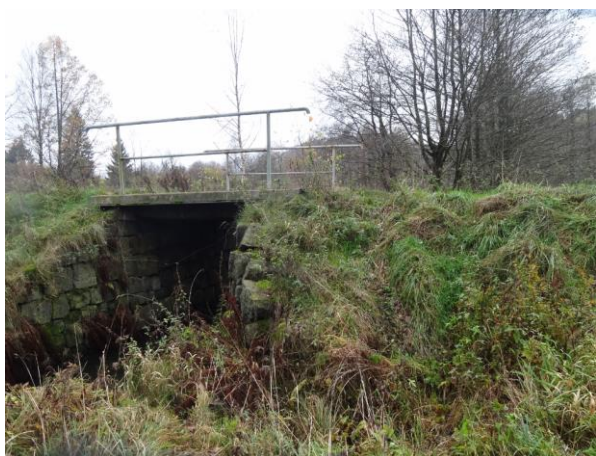
Obr. 56. Most v ř. km 4,258 (-737335, -940576)
