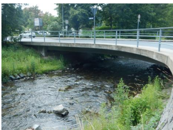
Obr. 8. Silniční most v ř. k. 13,307 (-742212, -944174)
