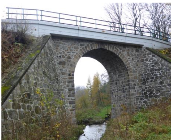
Obr. 80. Křížení s železničním mostem (-734743, -943423)
