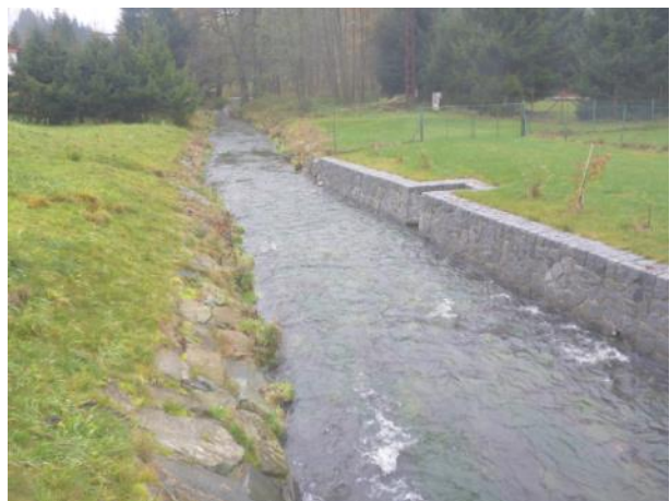
Obr. 21. Pod mostem pod Vilémovem (-735556, -942776)
