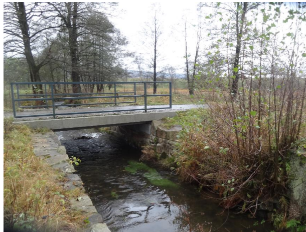
Obr. 65. Silniční most v ř. km 7,905 (-735487, -938605)
