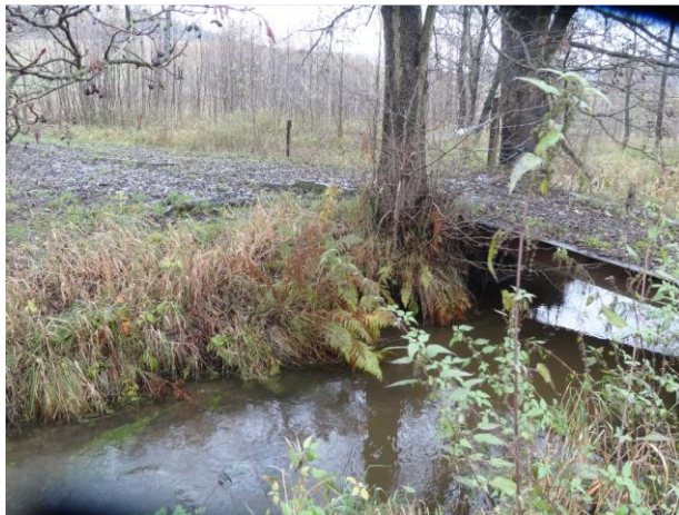
Obr. 64. Mostek v lese v ř. km 7,639 (-735375 -938847)
