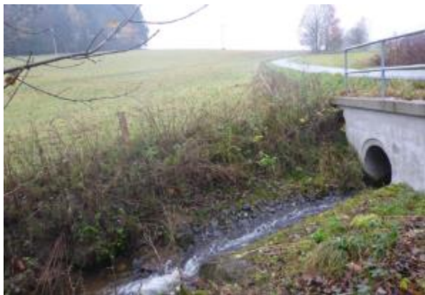
Obr. 143. Výtok z pod mostu (-732762, -939049)
