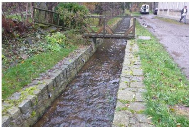
Obr. 176. Obdélníkové zděné koryto s lávkou v dolní části úseku (-731042, -942217)
