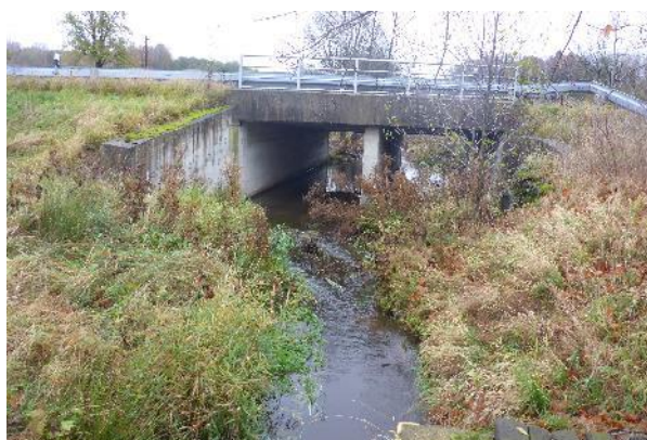
Obr. 181. Silniční most II/266 v ř.km 2,377 – konec úsek
