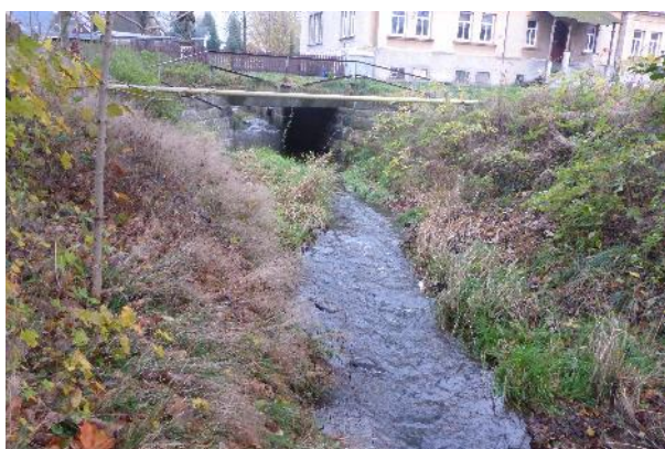
Obr. 156. Most v ř.km 0,533 (ul. Brtnická) (-731746, -942956)
