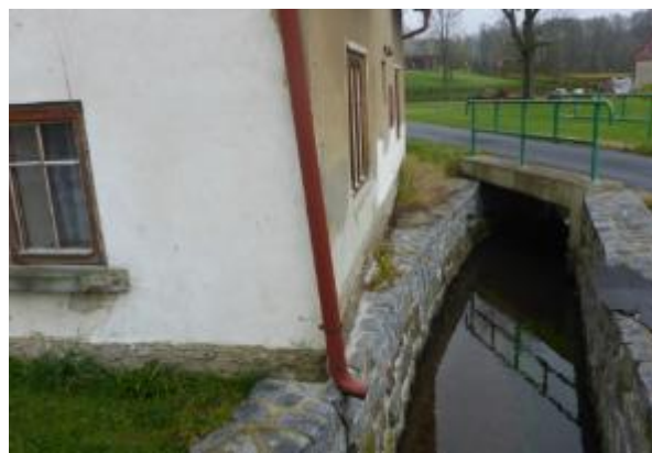
Obr. 136. Šikmý nátok na most v ř. km 4,516 (-732636, -940059)
