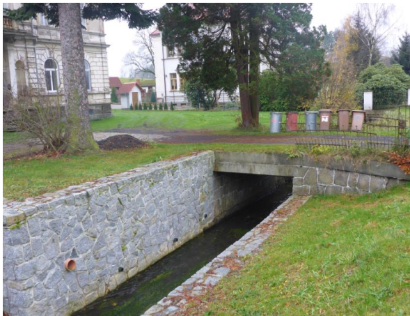
Obr. 121. Propustek ř. km 2,778 (-733465, -941014)
