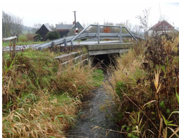
Obr. 69. Most v ř. km 8,932 (-735809, -937765)
