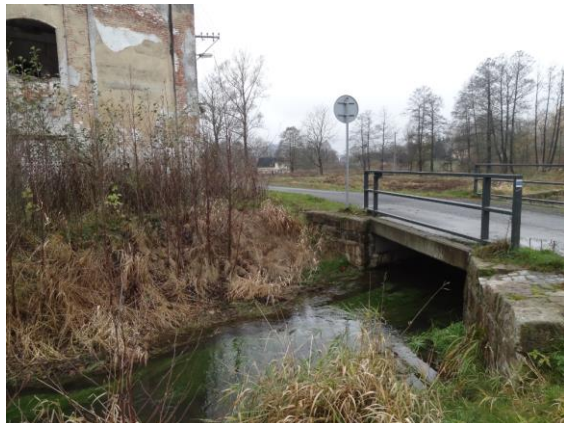
Obr. 58. Silniční most v ř. km 5,610 (-736502, -939729)
