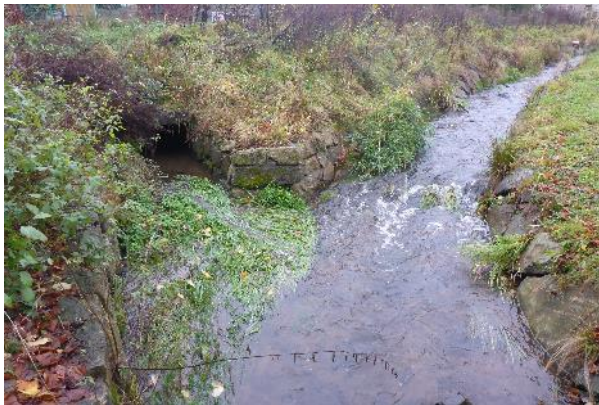
Obr. 174. Lichoběžníkové koryto s pravostranným přítokem v ř.km 1,693 (-731096, -942262)
