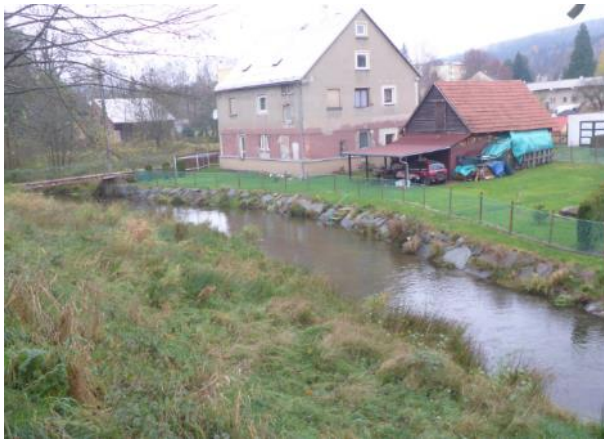
Obr. 22. Pohled na opevnění kamennou rovnaninou (-735121, -942764)
