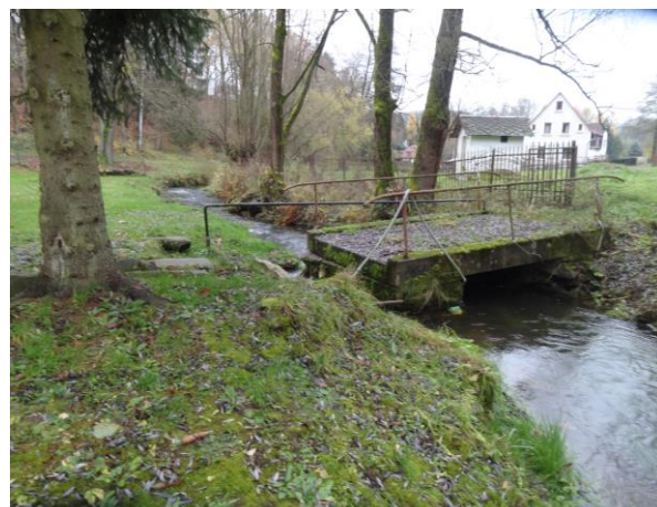
Obr. 55. Lávka v ř. km 3,781 (-737584, -940727)
