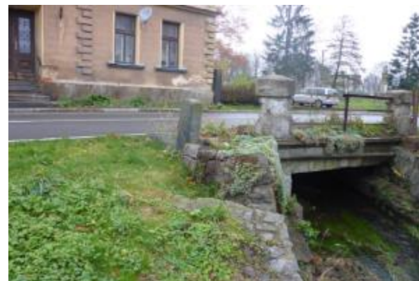
Obr. 126. Vyústění z propustku pod silnicí (-733171, -940677)
