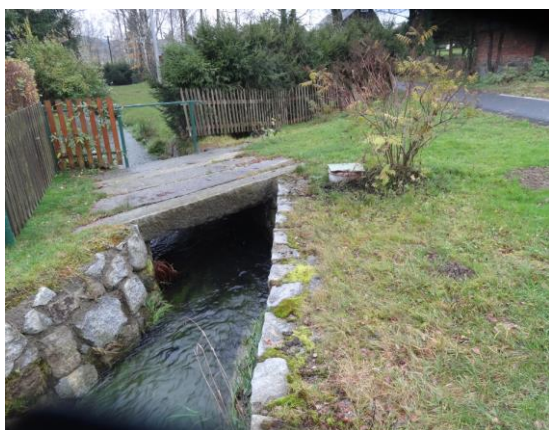
Obr. 60. Kamenná lávka ř. km 6,217 (-736136, -939416)
