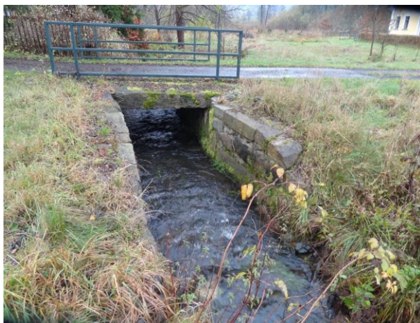
Obr. 66. Most v ř. km 8,081 (-735474, -938438)
