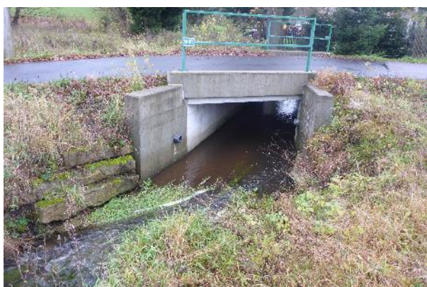
Obr. 180. Most M-01 v ř.km 2,162
