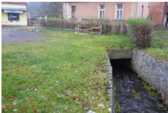
Obr. 127. Vtok do propustku (-733178, -940653)
