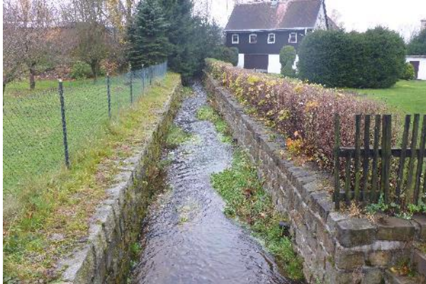
Obr. 160. Obdélníkové zděné koryto (-731574, -943001)
