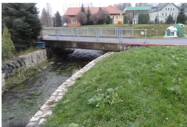
Obr. 52. Most v ř. km 2,579, upravené obdélníkové koryto (-737951, -941448)
