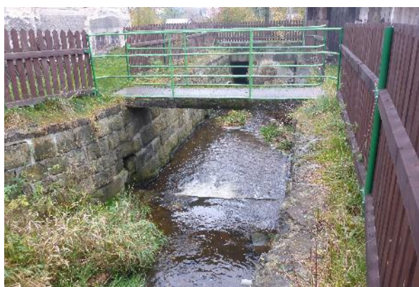
Obr. 157. Obdélníkový profil s lávkou nad mostem Brtnická (-731687, -942969)
