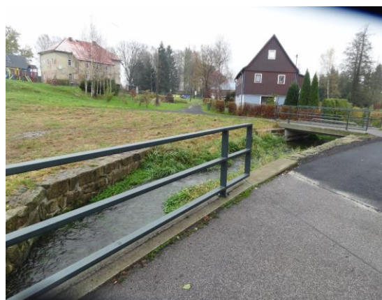
Obr. 61. Dva silniční mosty v ř. km 6,285 (-736087, -939378)
