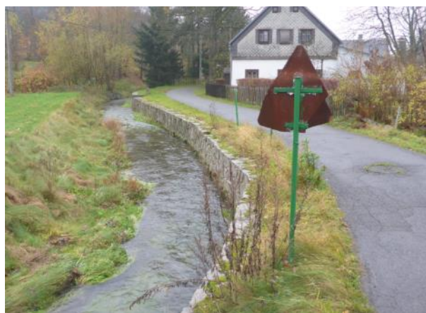
Obr. 28. Pravobřežní opěrná zeď (-733512, -942738)
