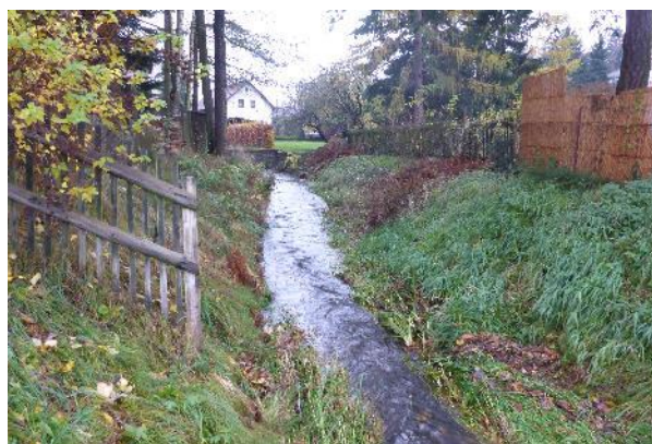
Obr. 149. Pohled od ústí do Vilém. potoka (-732159, -943125)
