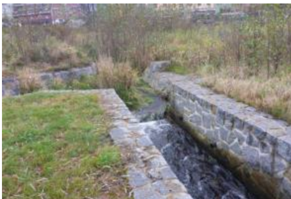
Obr. 125. Zaústění obtok. ramene ř. km 3,301 (-732904, -940699)
