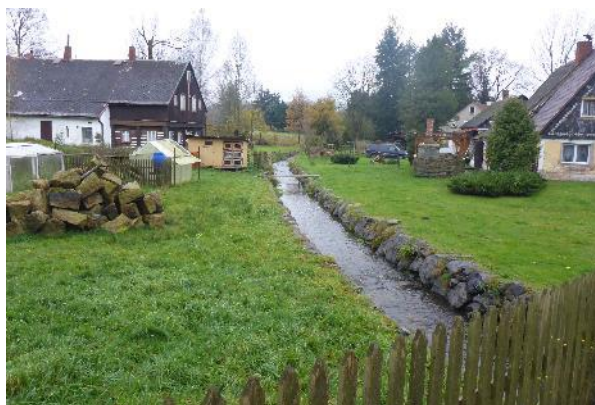
Obr. 167. Lichoběžníkové koryto opevněné kamennou rovnaninou (-731250, -942742)
