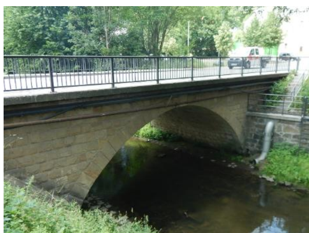
Obr. 9. Silniční most v ř. k. 14,800 (-740983, -944348)
