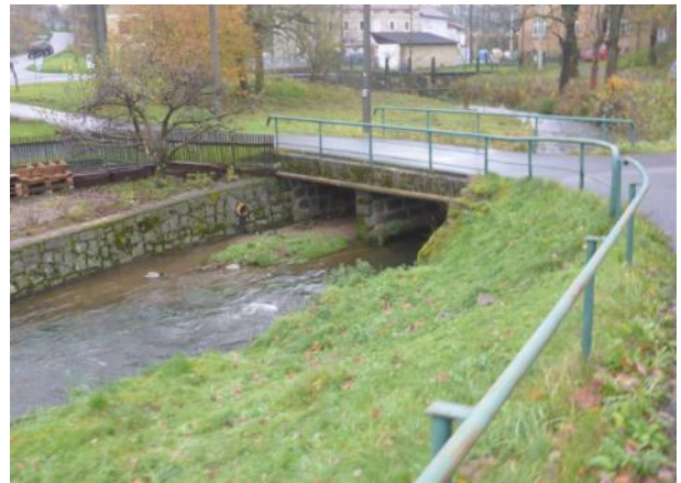
Obr. 23. Mostní profil s pravobřežní opěrnou zdí (-735046, -942783)
