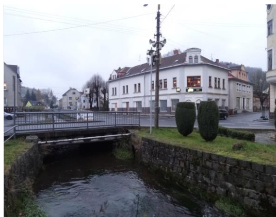
Obr. 43. Most přes potok, tok lemován silnicí (-738545, -943242)
