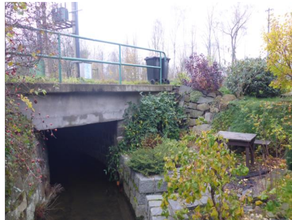
Obr. 122. Dlouhý propustek ř. km (-733326, -940958)
