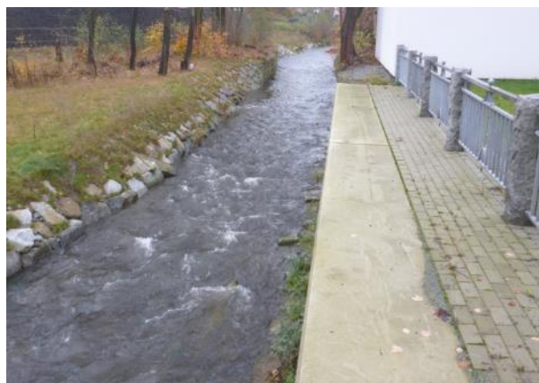
Obr. 17. Pohled na obestavěné koryto (-738602, -943576)
