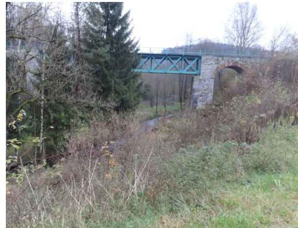
Obr. 51. Železniční most nad údolím (-737996, -942071)
