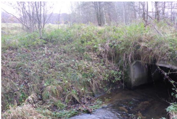
Obr. 113. Mostek u lesa, ř. km 1,287 (-734036, -941858)
