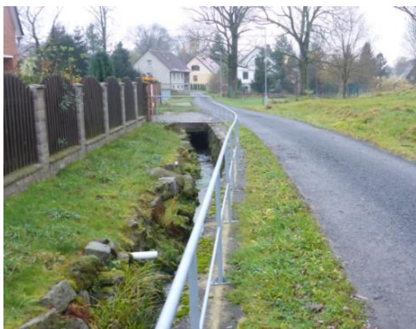
Obr. 108. Koryto podél komunikace (-731661, -946558)
