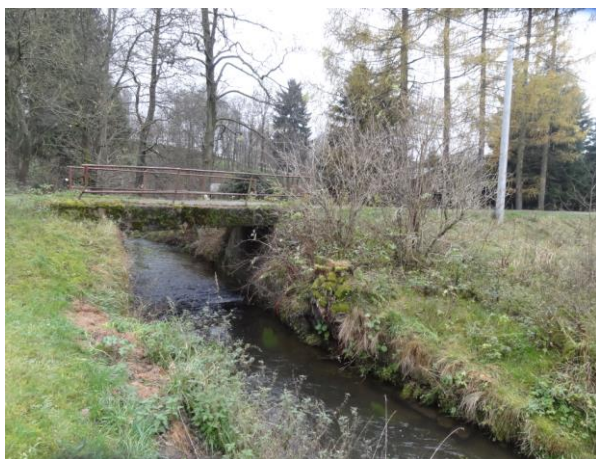
Obr. 54. Silniční most ř. km 3,573 (-737485, -940894)
