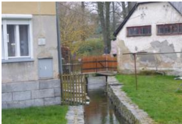
Obr. 133. Lávka s plůtkem, ř. km 4,079 (-732690, -940385)
