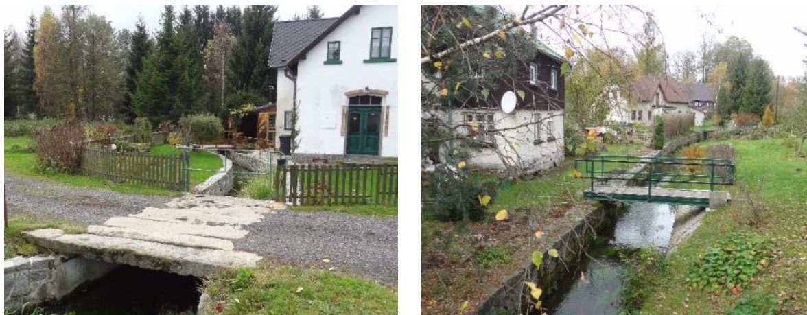
Obr. 191 Ohrožená zástavba zvýšenými průtoky - Lipová
