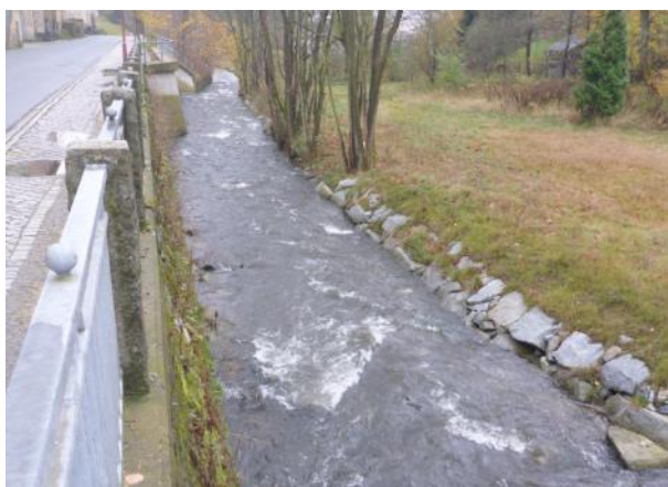
Obr. 14. Pohled na obestavěné koryto (-738646, -943643)
