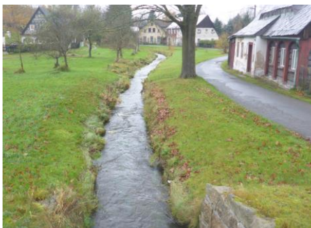
Obr. 27. Pohled na opevnění kamennou rovnaninou (-733617, -942779)
