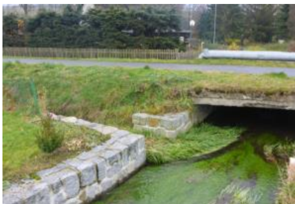
Obr. 135. Zaústění do potoku před mostem v ř. km 4,354 (732553, -940148)
