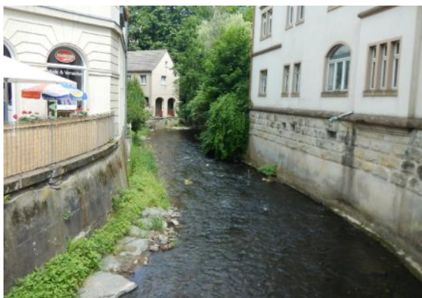
Obr. 10. Pohled na obestavěné koryto (-739918, -944301)
