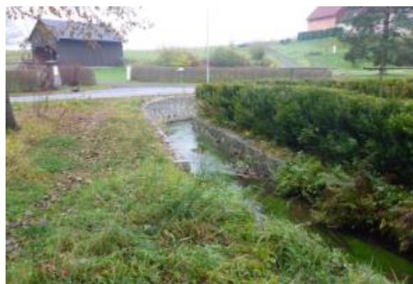
Obr. 138. Konec opevněného koryta v ř. km 5,113 (-732641, -939590)
