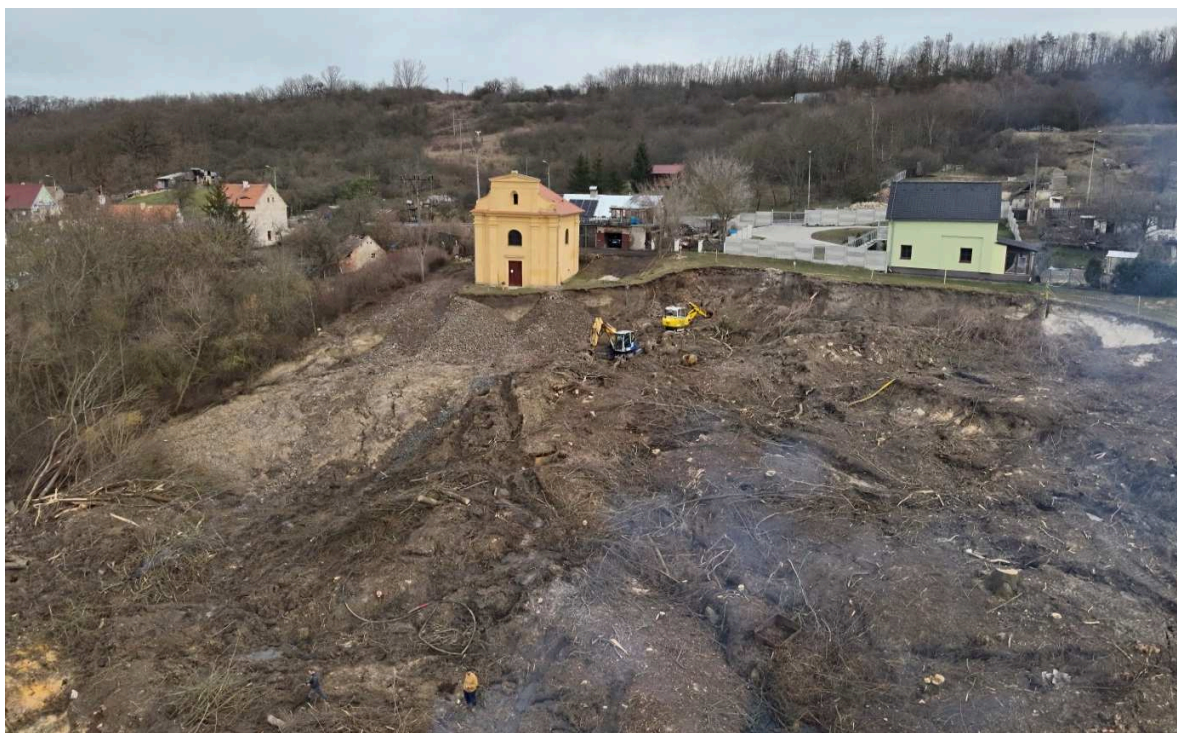
Celkový pohled na sesouvající svah
