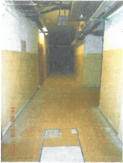
chodba v PP
