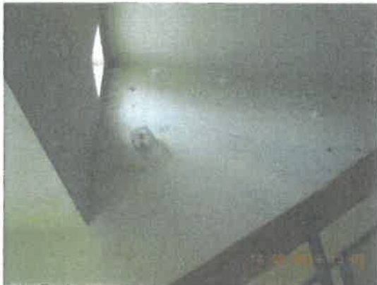
zatékání střechou
