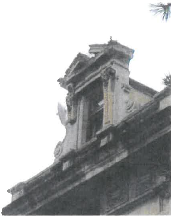
Foto 13_vikýř v ose boční fasády.JPG
