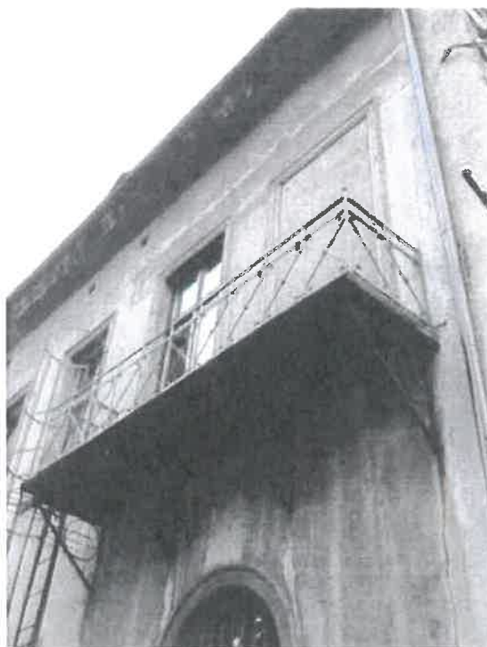
Foto 07_balkon dvorní fasády.JPG
