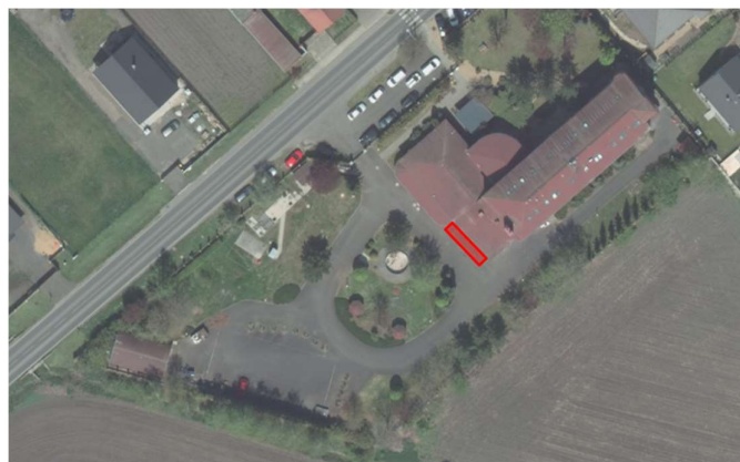
Obrázek 23: Umístění přístavby pro umístění technologie FVE
