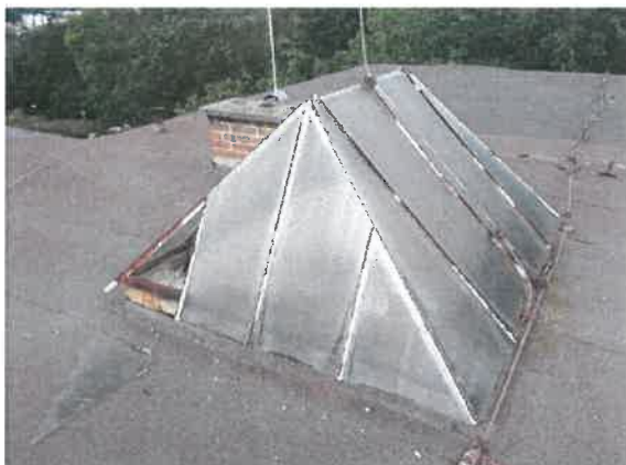
foto /3/ Pohled na světlík střechy S1
