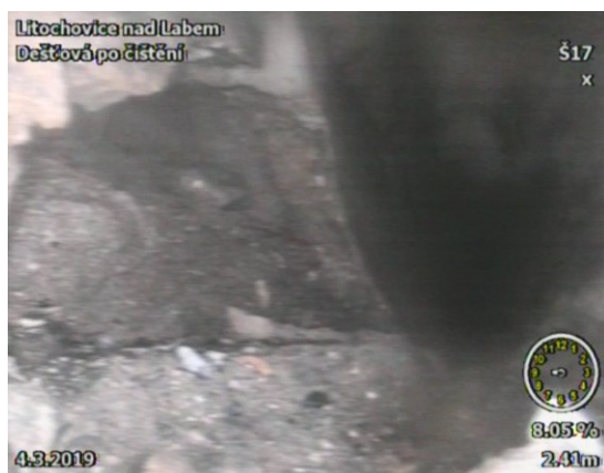
Chybějící dno a stěny – exfiltrace
