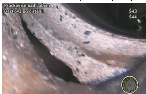
Kaverna pod potrubím
