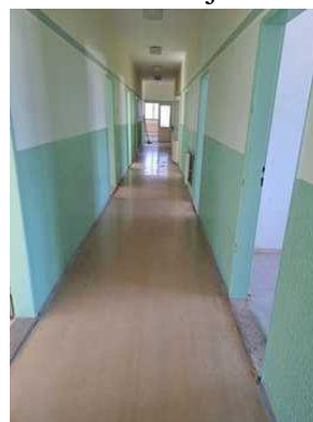
admin. objekt 2. NP
