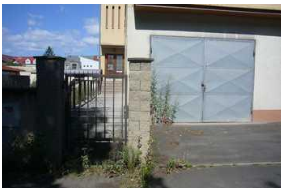
garáž v admin. budově
