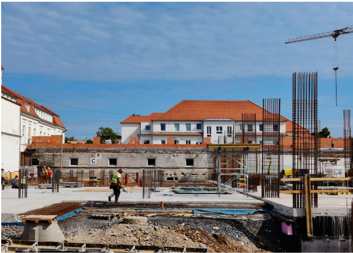
Fotografie z probíhající výstavby:
