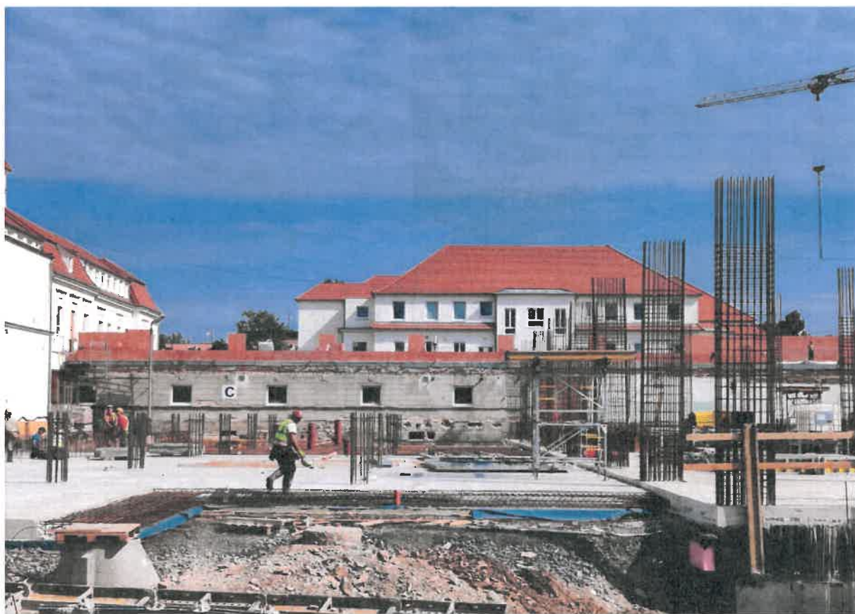
Fotografie z probíhající výstavby:
