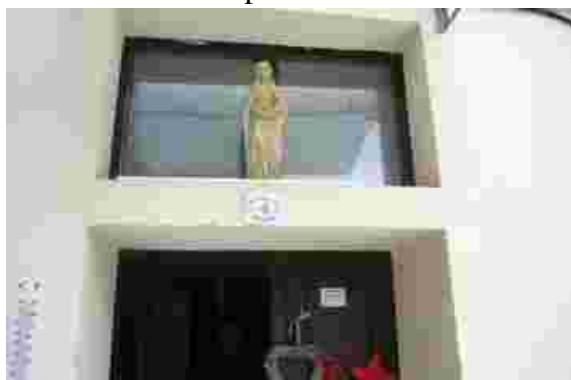
vstup do objektu
