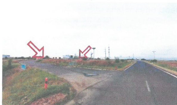
pohled SV ze silnice č. 607
