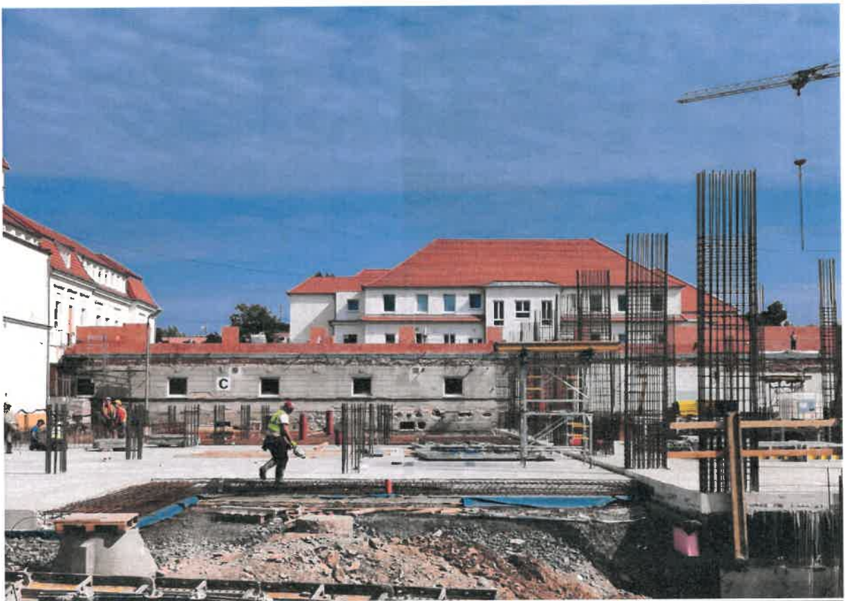
Fotografie z probíhající výstavby:
