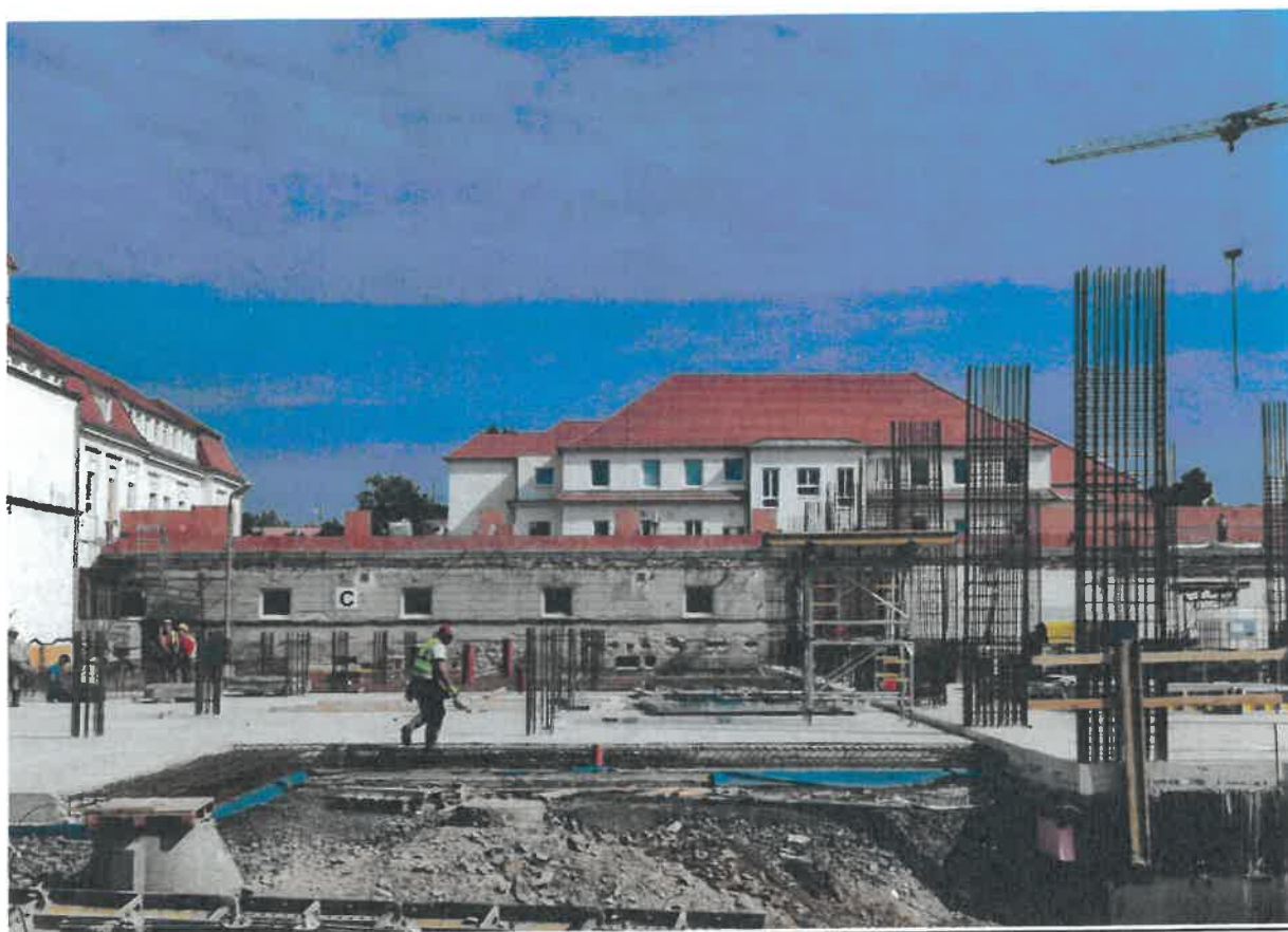
Fotografie z probíhající výstavby:
