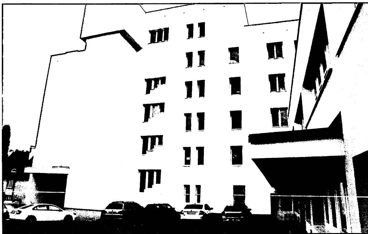
Fotografie po dokončení rekonstrukce:
