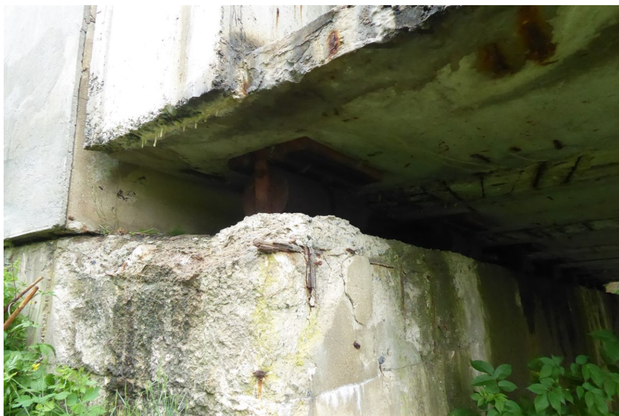
úložný práh opěry č. 1
