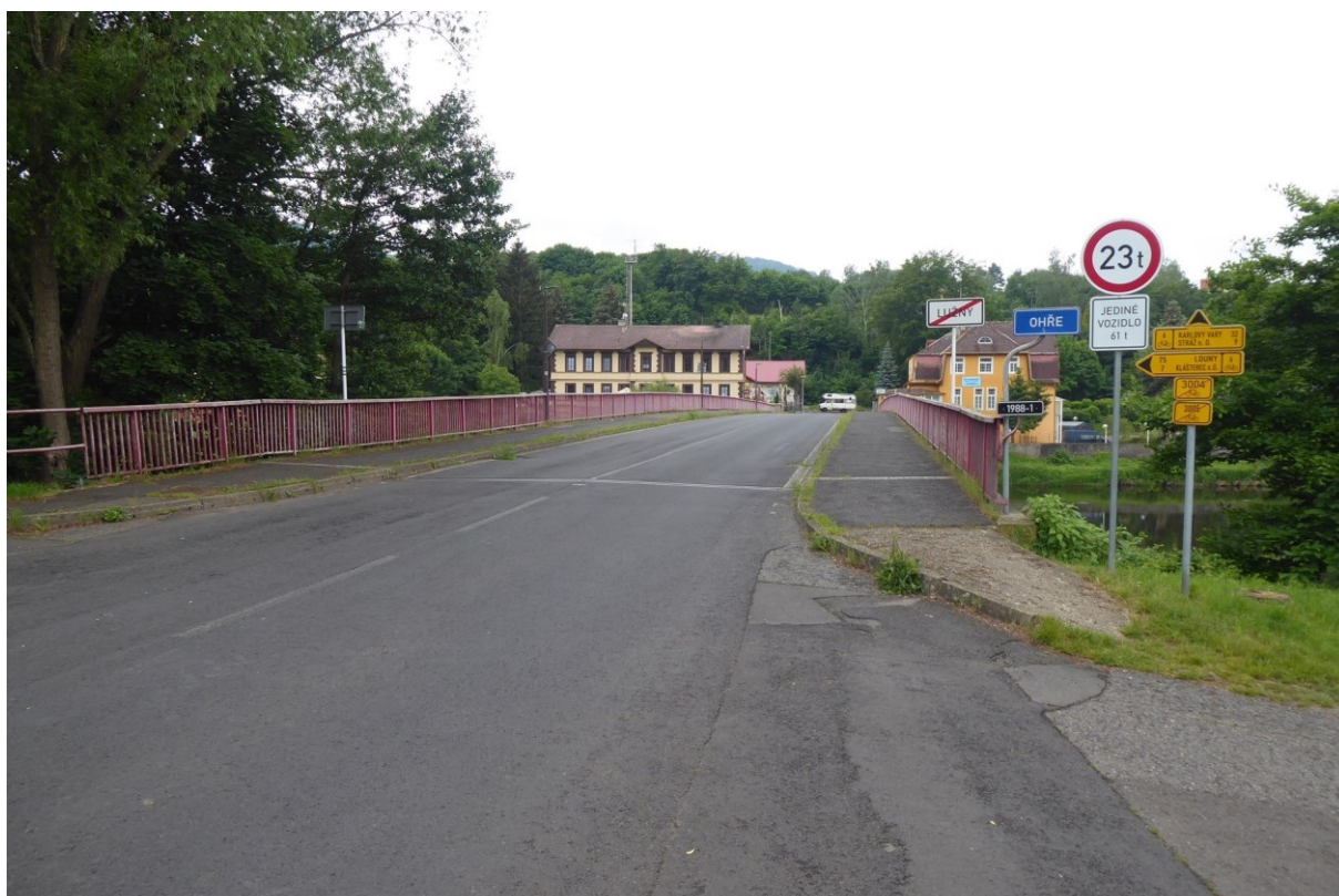
pohled na most ve směru staničení
