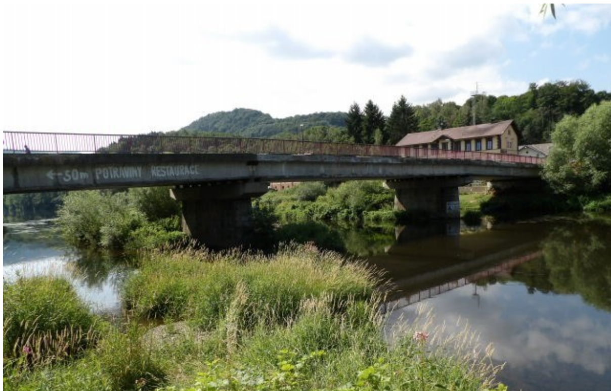
celkový pohled na most
