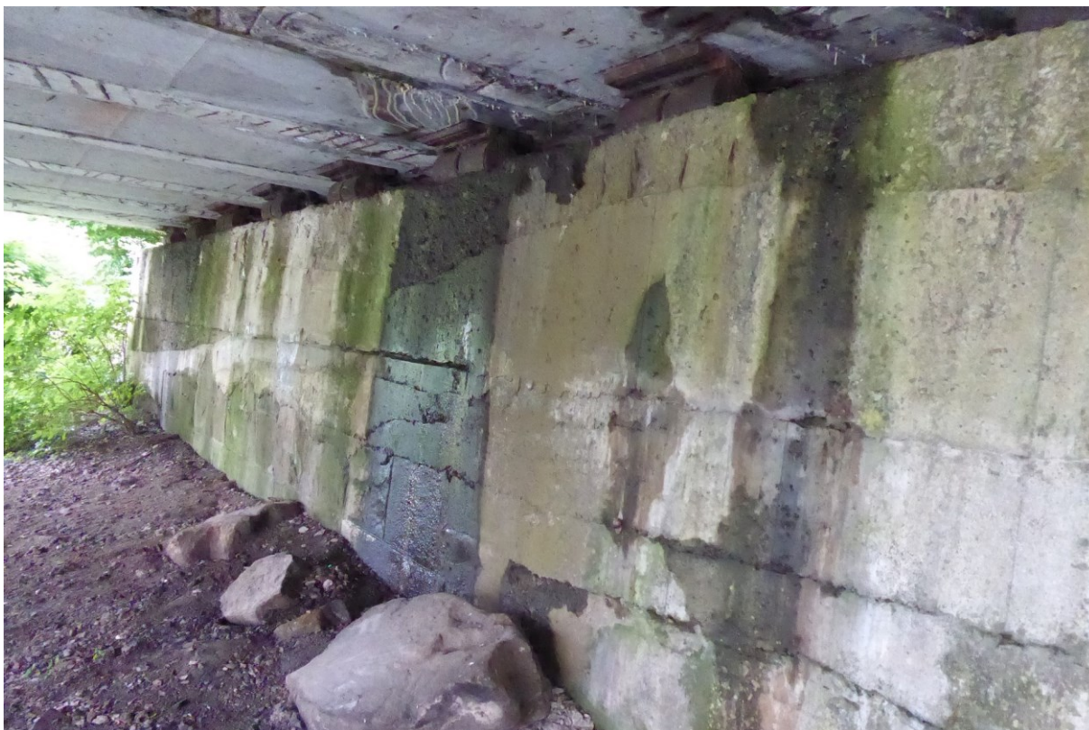
pohled na opěru č. 1
