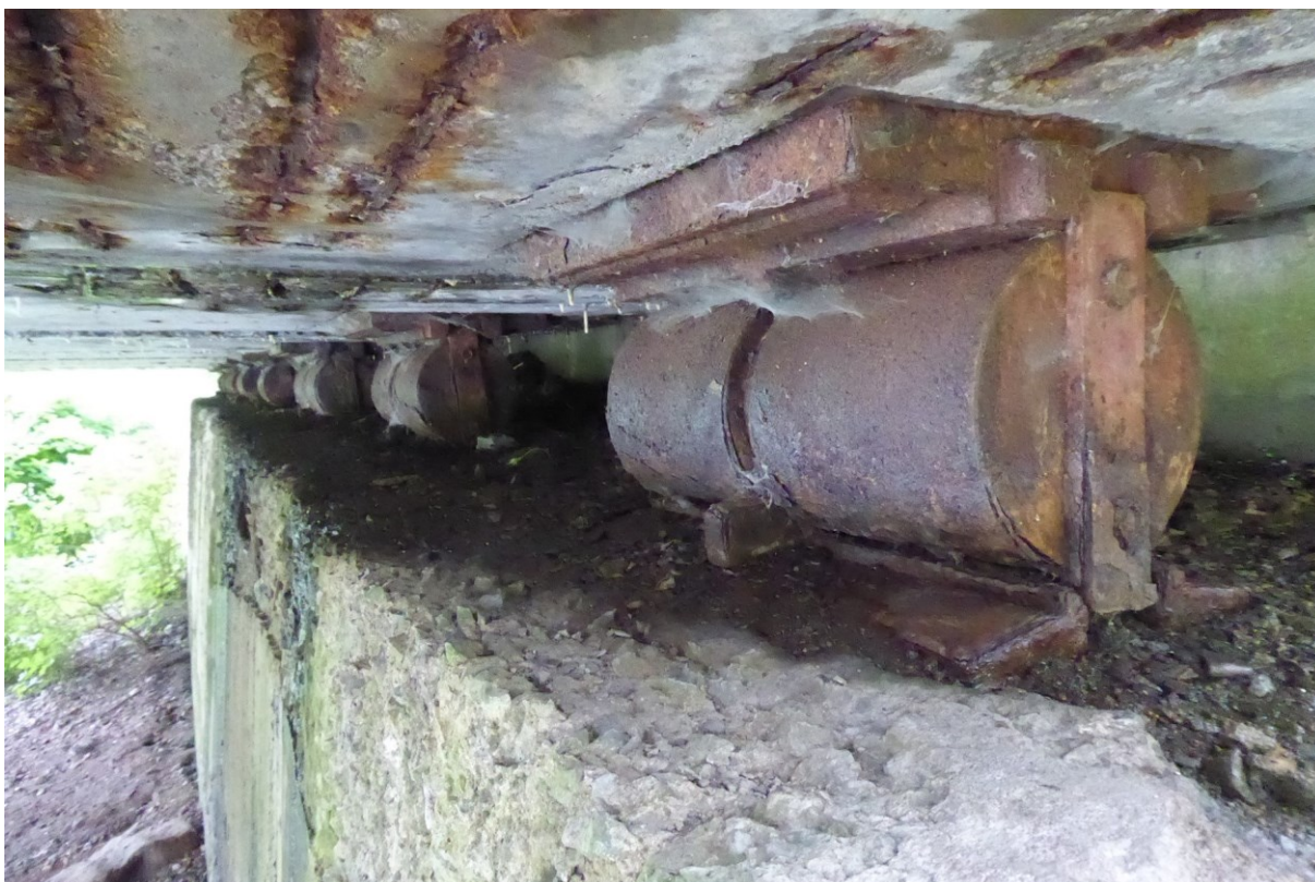
pohled na ložiska úložný práh opěry č. 1
