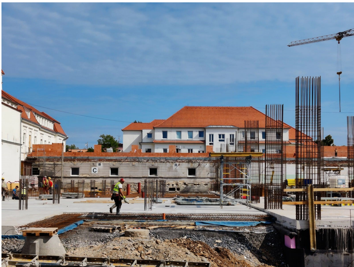
Fotografie z probíhající výstavby:
