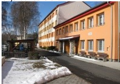
Objekt ul. Javorová
