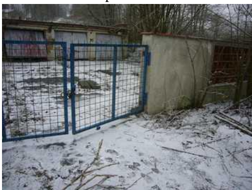
vstup do dvorního traktu
