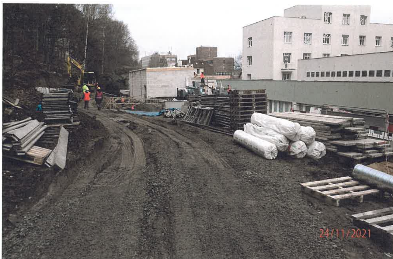
Fotografie z probíhající stavby:
