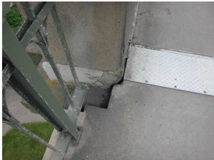
081 svršek mostu - pravá strana
