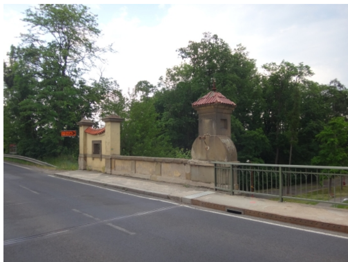
006 svršek mostu - levá strana
