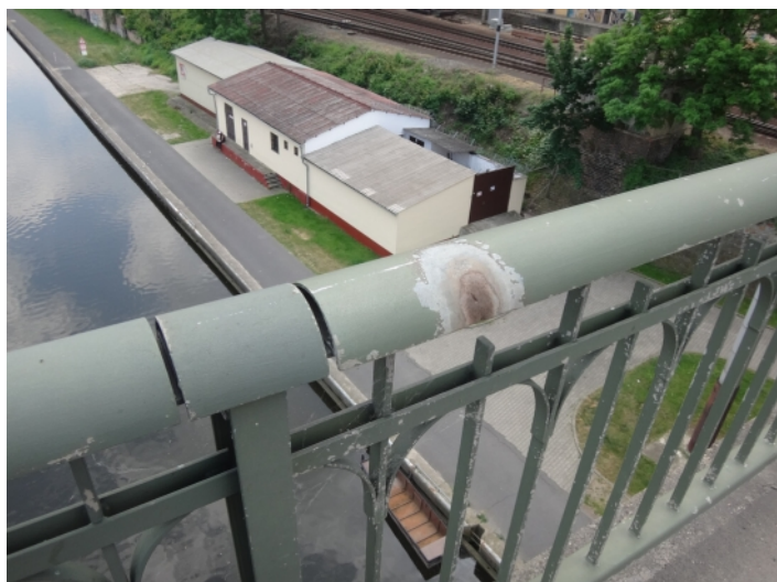
082 svršek mostu - pravá strana
