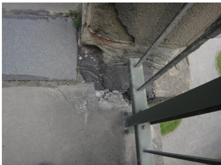
076 svršek mostu - pravá strana
