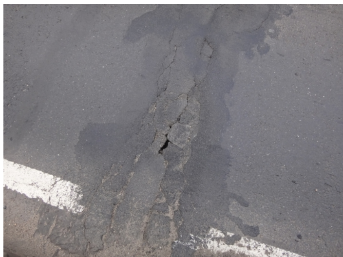
077 svršek mostu - pravá strana
