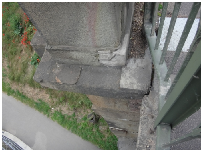
004 svršek mostu - levá strana
