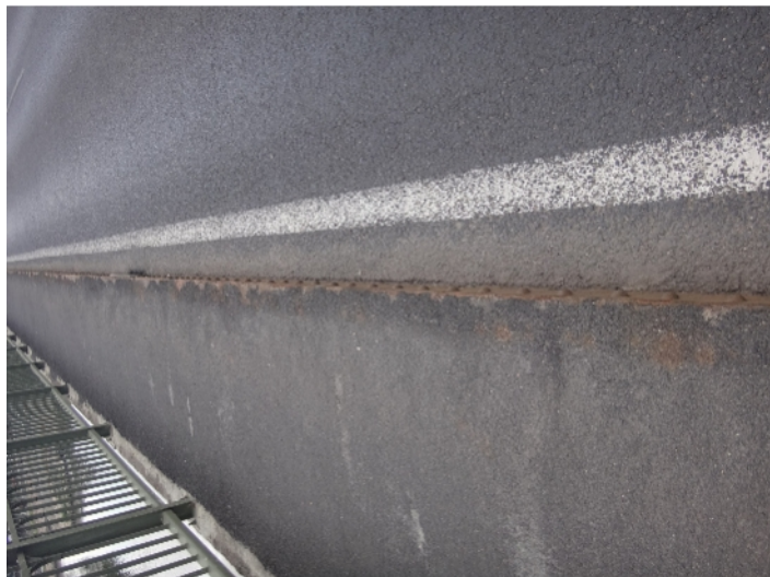
037 svršek mostu - levá strana
