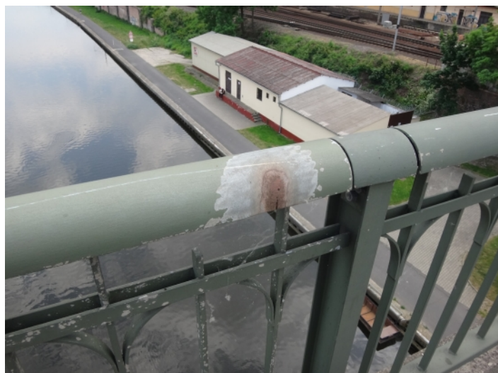
083 svršek mostu - pravá strana
