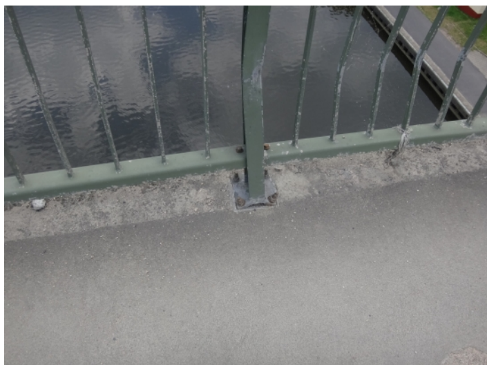
084 svršek mostu - pravá strana
