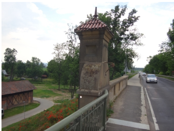
005 svršek mostu - levá strana
