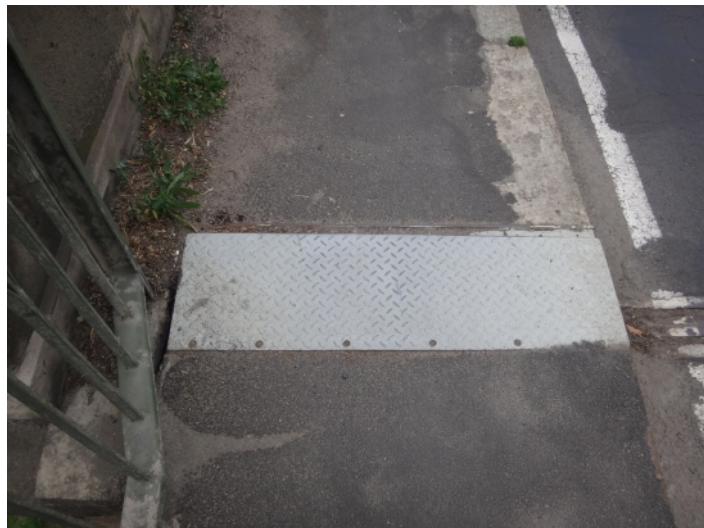
002 svršek mostu - levá strana
