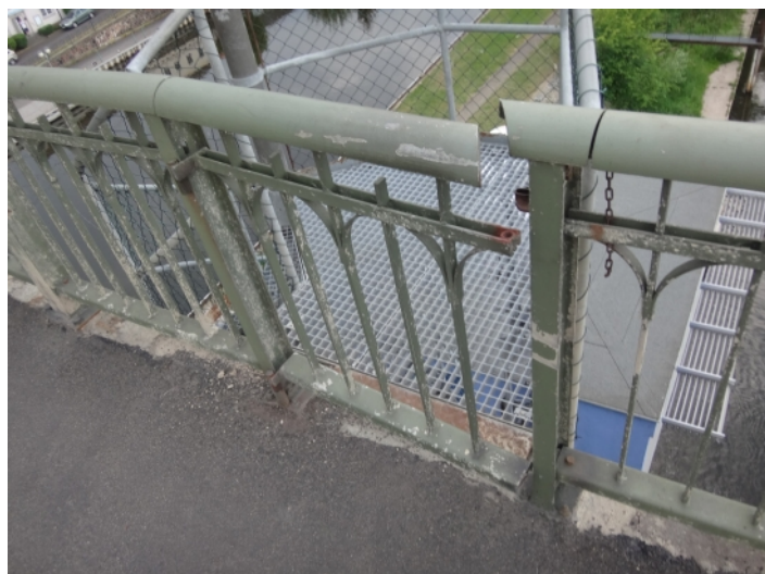
040 svršek mostu - levá strana
