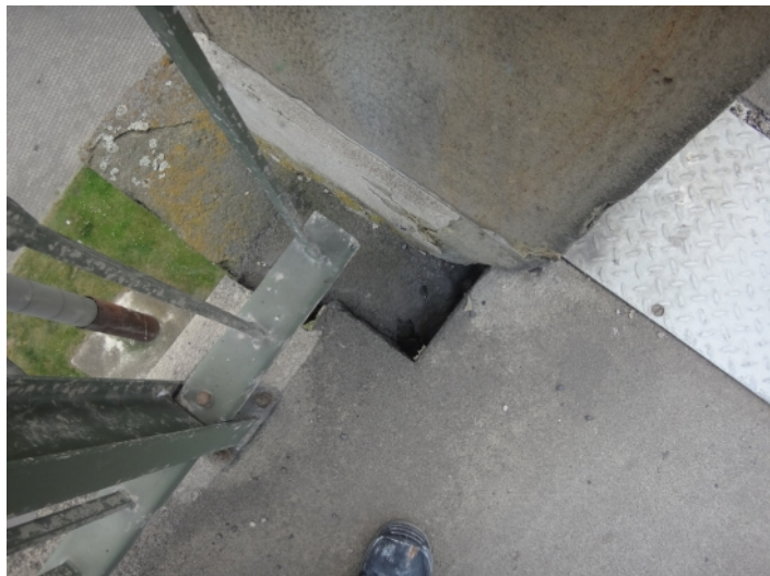
080 svršek mostu - pravá strana
