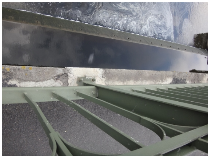
039 svršek mostu - levá strana
