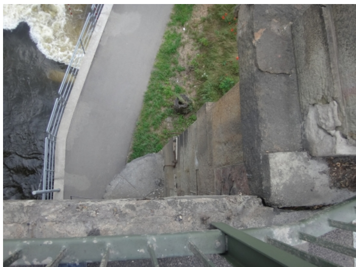
003 svršek mostu - levá strana
