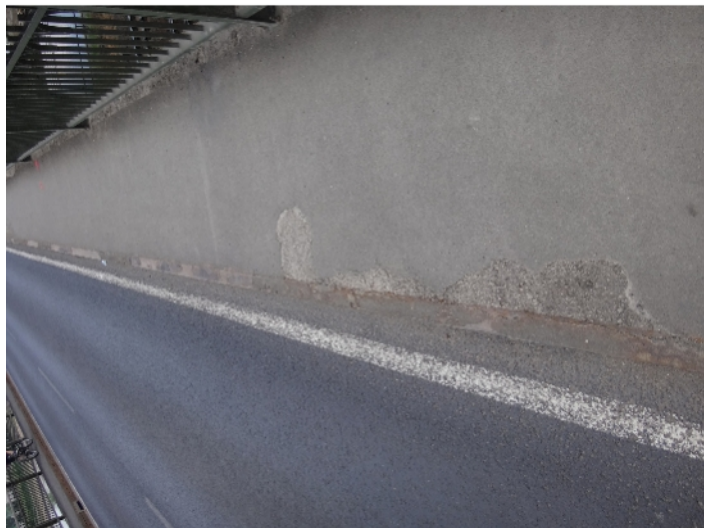
074 svršek mostu - pravá strana
